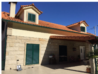
Local de monitorização V1
