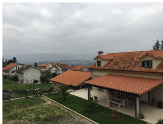
Local de monitorização R1
