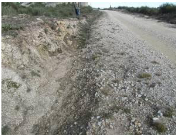
Fotografias 4.13 e 4.14 – Exemplo de valetas sem revestimento, observando-se à esquerda como é efetuado o encaminhamento do escoamento para a linha de água mais próxima
