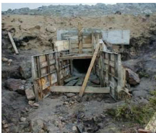
Fotografias 4.17 e 4.18 – Exemplo da descarga de uma passagem hidráulica (boca de saída)
