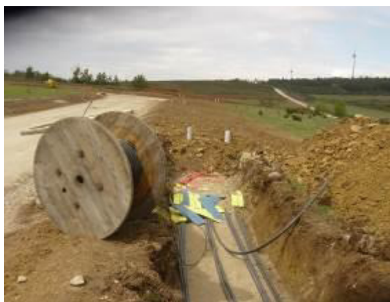
Fotografias 4.3 e 4.4 – Exemplo de vala para instalação de cabos elétricos
