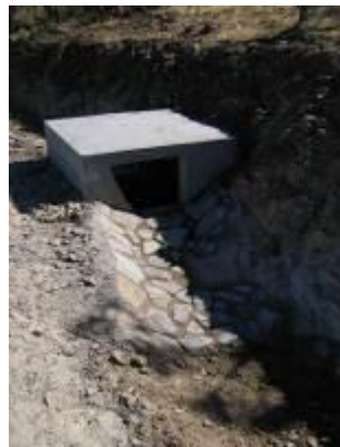
Fotografias 4.15 e 4.16 – Exemplo de uma caixa de queda de uma passagem hidráulica
