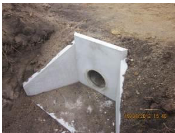
Fotografias 4.15 e 4.16 – Exemplo de uma caixa de queda de uma passagem hidráulica
