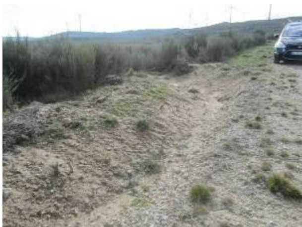
Fotografias 4.13 e 4.14 – Exemplo de valetas sem revestimento, observando-se à esquerda como é efetuado o encaminhamento do escoamento para a linha de água mais próxima
