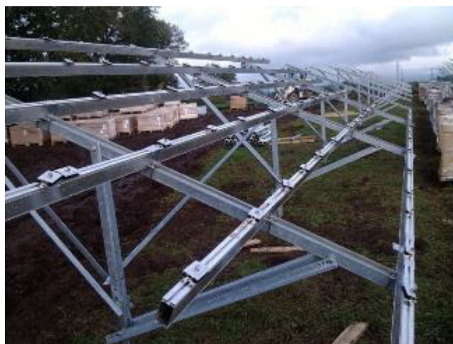
Fotografia 4.21 – Exemplo de montagem da estrutura de suporte dos módulos FV
