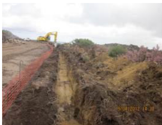
Fotografias 4.3 e 4.4 – Exemplo de vala para instalação de cabos elétricos
