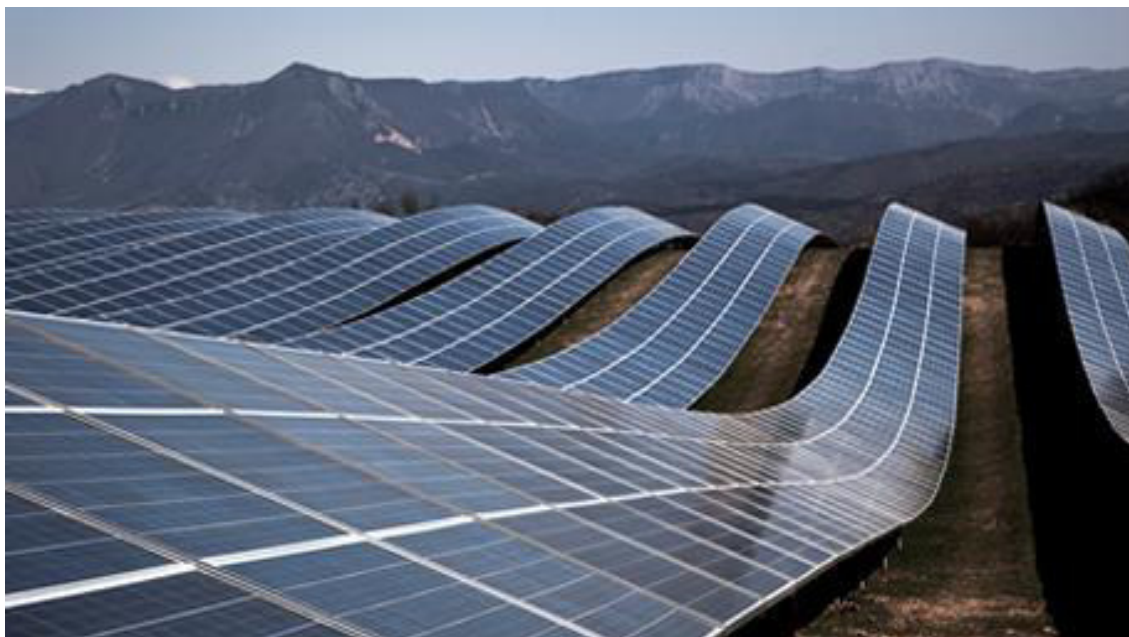
Fotografia 4.12 – Painéis fotovoltaicos que acompanham a morfologia do terreno
