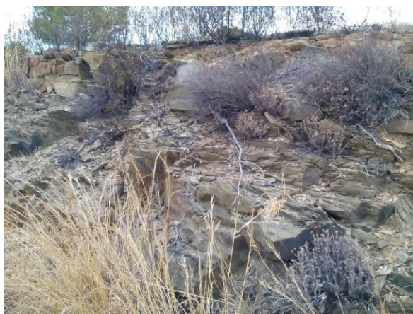
Fotografia 5.7 – Caminho CM 507 da área de estudo a cerca de 1,5 km a sul de Tesouro. Observam-se fragmentos xistentos das camadas estratificadas alternados com pequenos blocos medianamente conservados.
