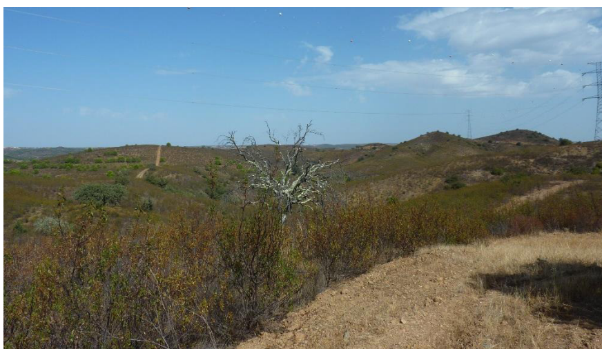
Fotografia 5.36 – Local de ligação da linha elétrica à Subestação da Central Fotovoltaica de Alcouthim
