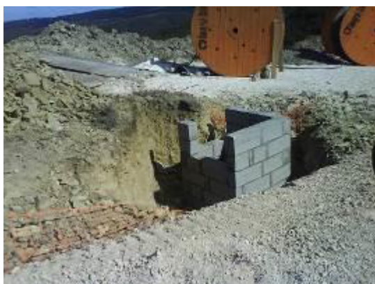
Fotografias 4.15 e 4.16 – Exemplo de uma caixa de queda de uma passagem hidráulica
