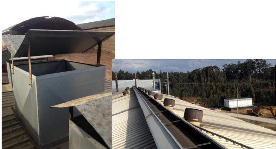
Figura 6.3 - Sistema de exaustão instalado na secção de Acabamentos e vista de alguns dos extratores instalados na cobertura (principais fontes ruidosas).
