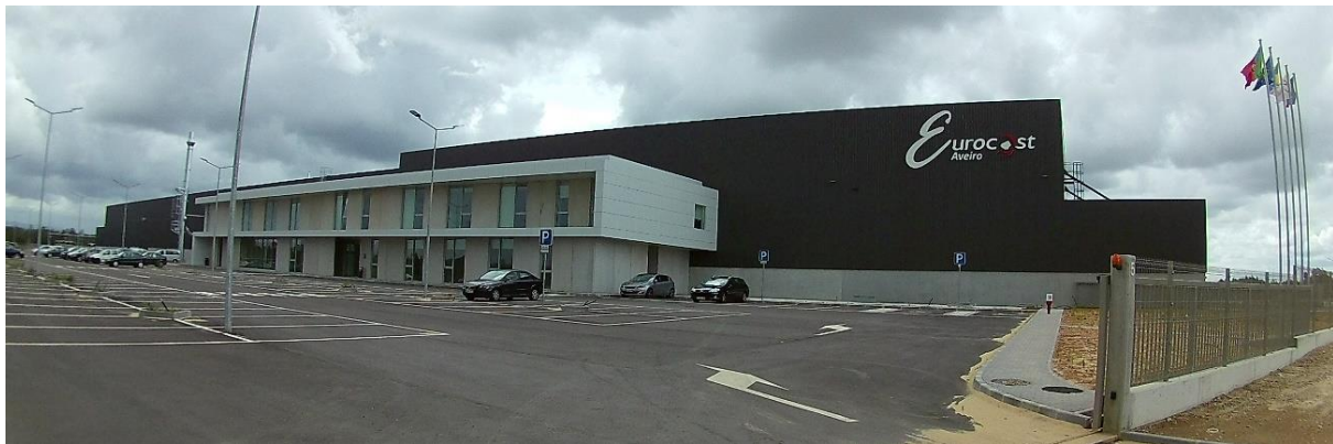
Figura 3 – Vista da Eurocast Aveiro, a partir de Norte.
