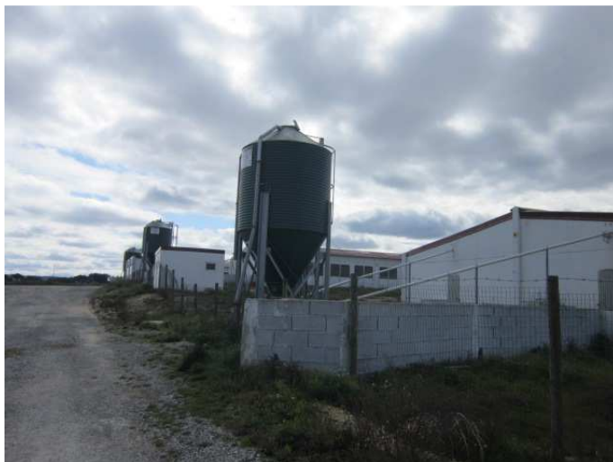
Fotografia 14: Vista geral dos silos
