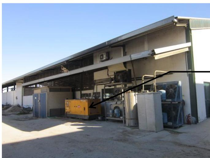
**Fotografia 34: Gerador de emergência.**
