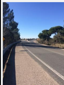
Figura 7 – Nó de ligação entre a EN120 e o IC1, onde localizará o acesso à “Aldeia das Cegonhas”
