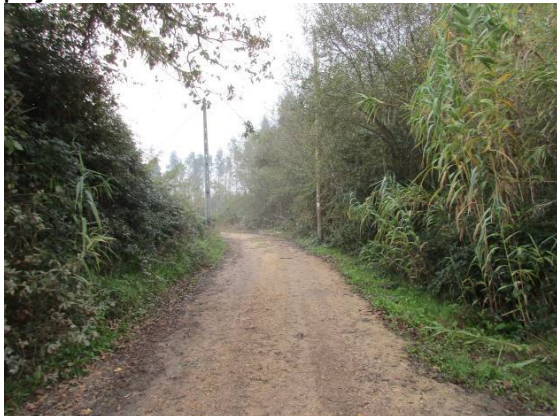
Fotografia 6 - Acesso existente, que atravessa a área do projeto no sentido sudeste-norte.
