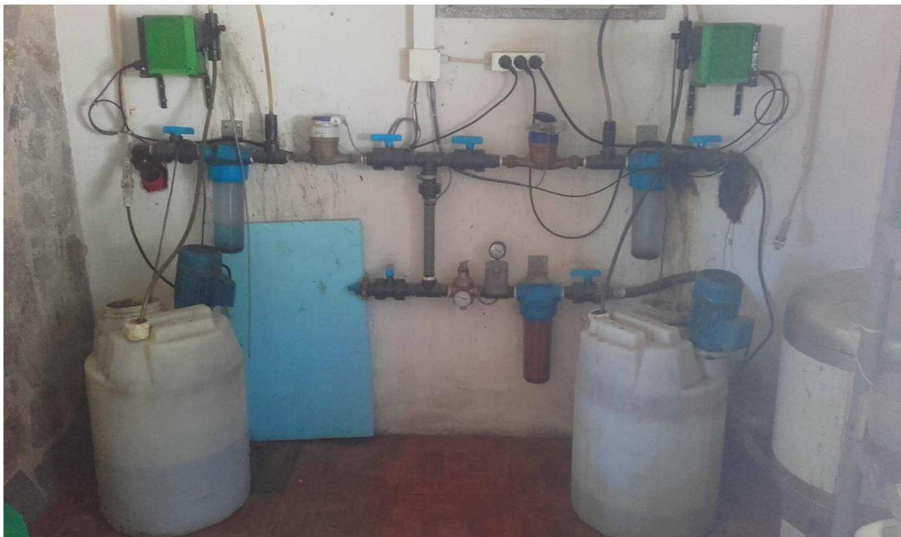
**Figura 8** - Sistema de desinfecção profilática das águas
