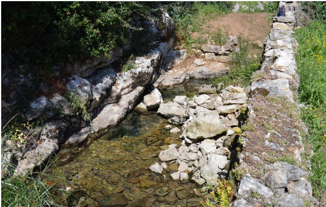
Fotografia 4 – Nascente da Chiqueda (imagem captada a 17 de junho de 2018).
