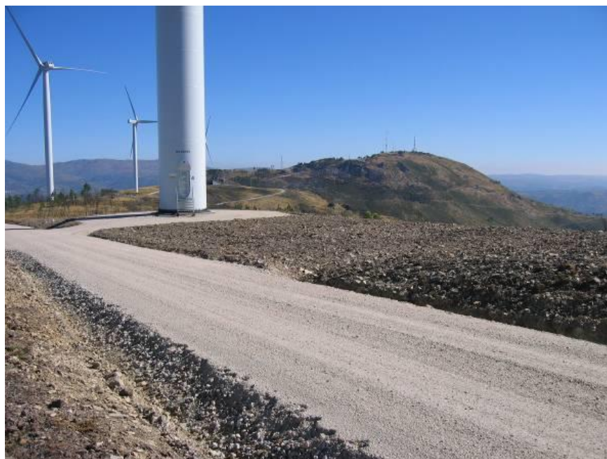
Fotografia 1 – Exemplo da plataforma de um aerogerador após a recuperação.
