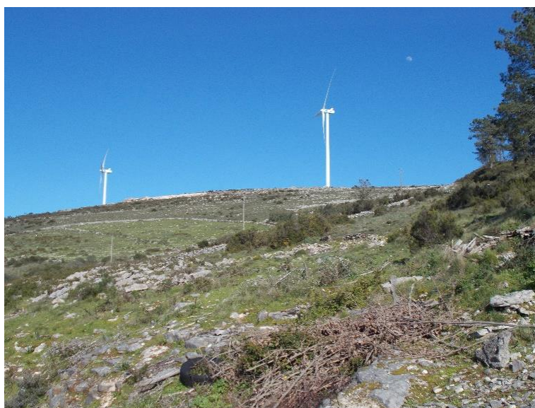
Fotografia 9 – Presença do parque eólico da Portela do Pereiro.
