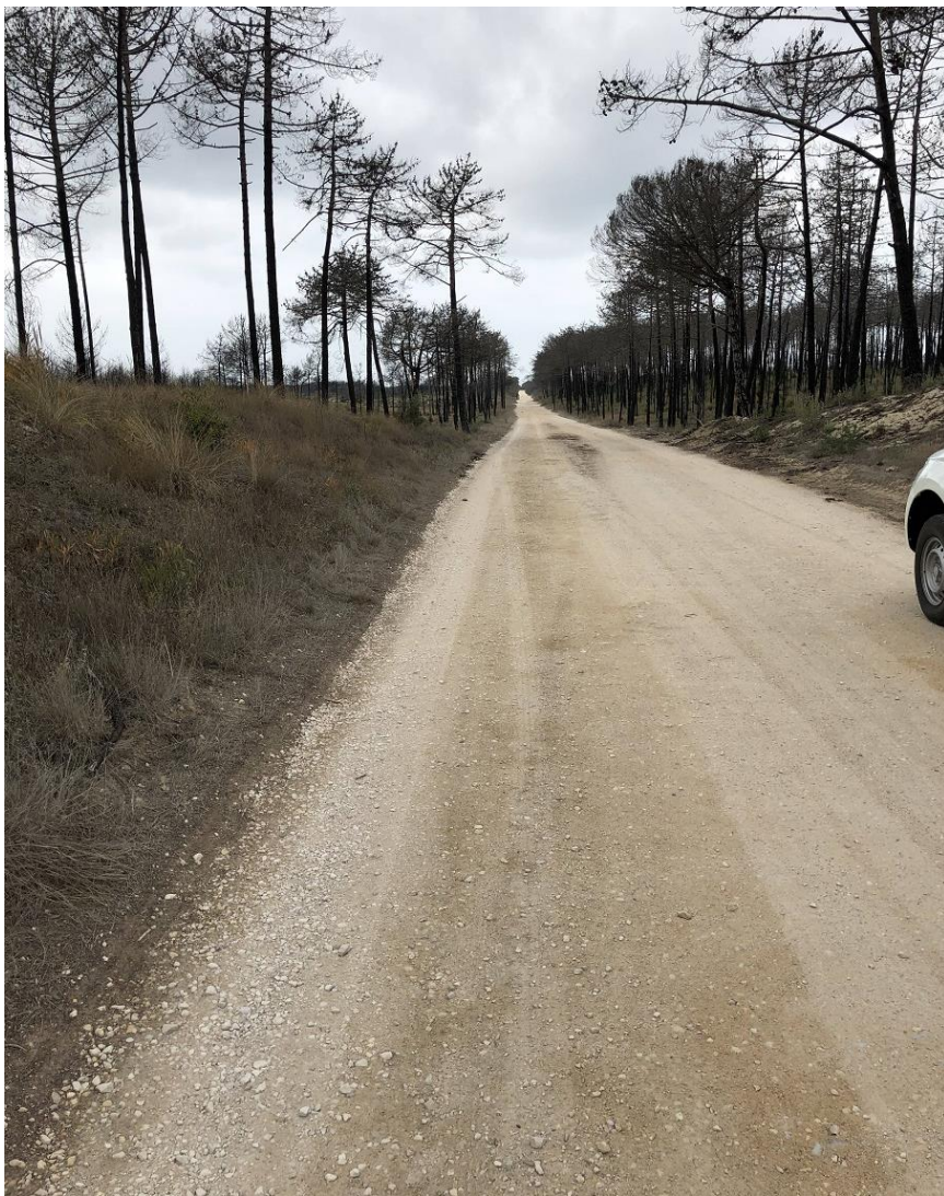
Estradão ao longo do qual se irão instalar os aerogeradores AG9, AG8 e AG7
