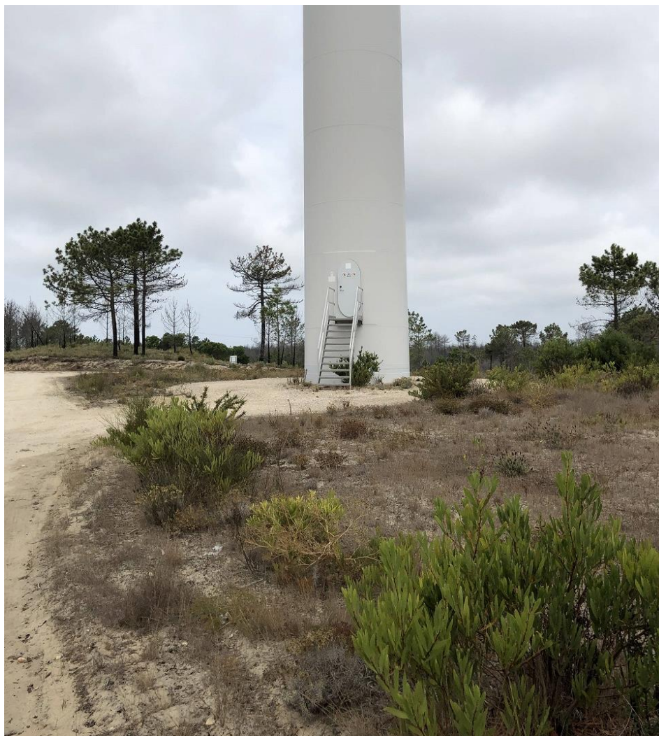
Parque Eólico da Tocha. Plataforma de aerogerador
