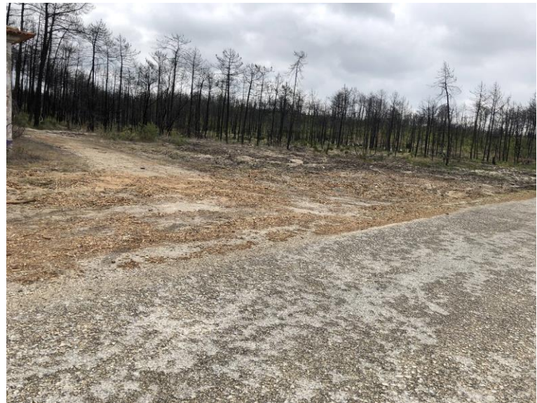
Espaço utilizado na obra para manobras para possibilitar a entrada no acesso aos aerogeradores AG9, AG8 e AG7
