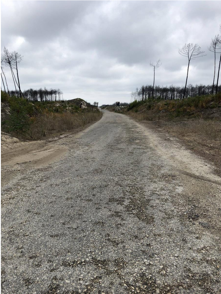
Acesso que será utilizado na fase de construção para chegar ao acesso dos aerogeradores AG9, AG8 e AG7
