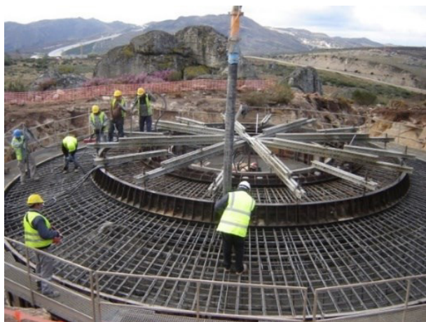
Fotografia 4 - Betonagem da fundação do aerogerador
