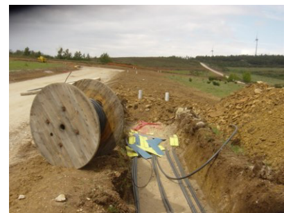
Fotografia 9 - Colocação dos cabos
