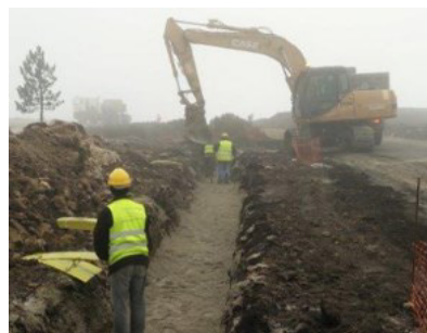
Fotografia 8 - Execução da base em areia
