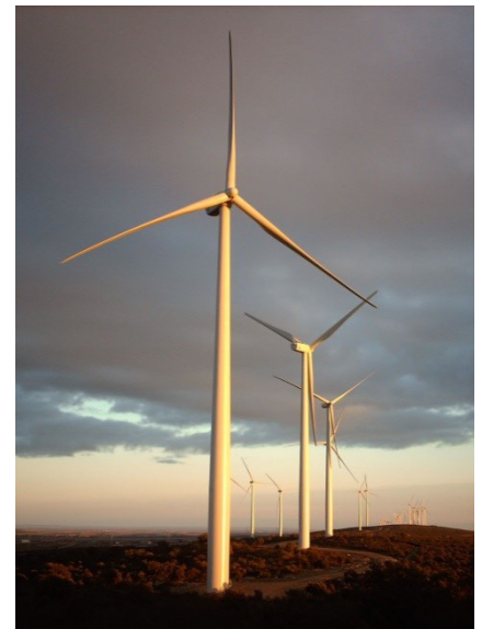
Fotografia 1 – Estrutura de um aerogerador
