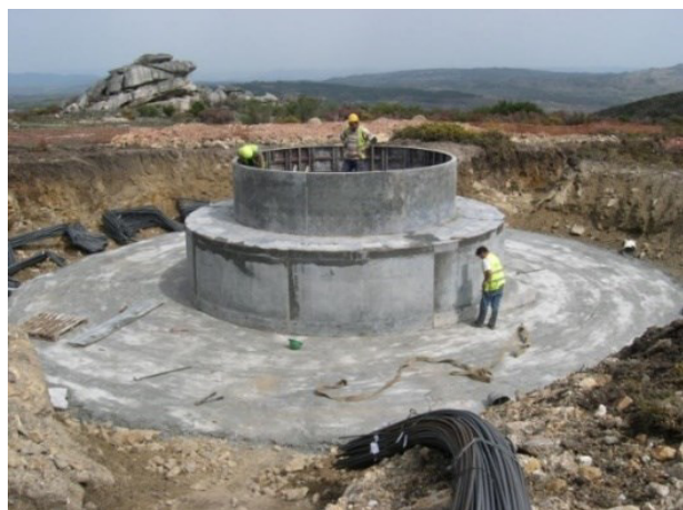
Fotografia 5 - Betonagem da fundação do aerogerador
