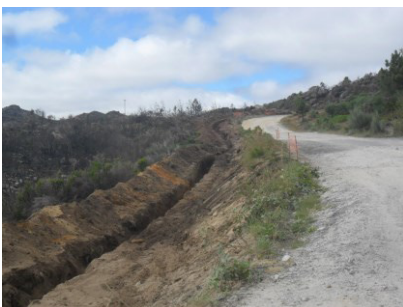
Fotografia 7 - Abertura da vala
