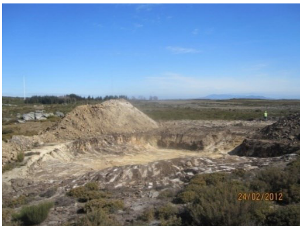
Fotografia 2 - Abertura do cabouco para a fundação do aerogerador
