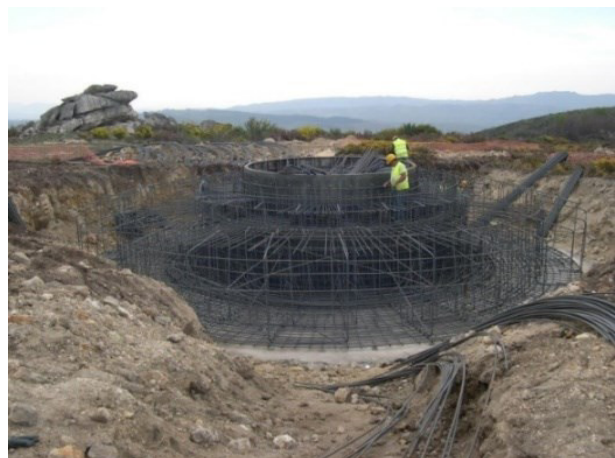
Fotografia 3 - Execução da armadura da fundação do aerogerador
