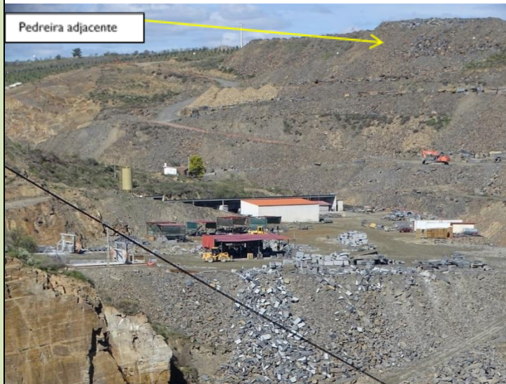
Vista da área atual de exploração a norte e pedreira adjacente
