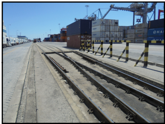
- Linha ferroviária - junto à portaria
