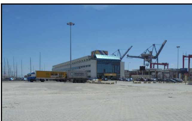
2 - Edifício Vasco da Gama (a demolir)
