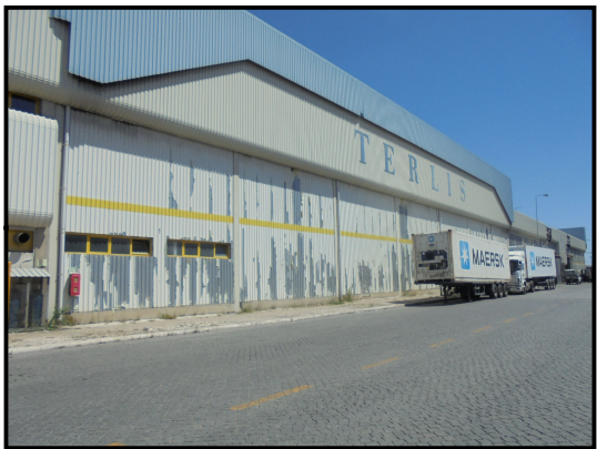
3 - Edifício da Terlis (a demolir)
