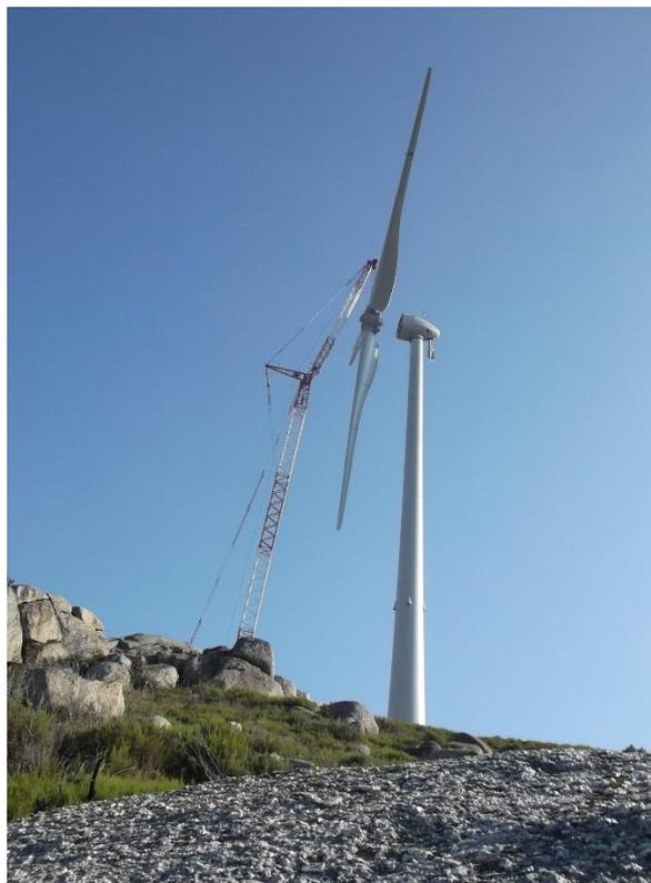
Fotografia 11 – Montagem da cabine e pás de um aerogerador.
