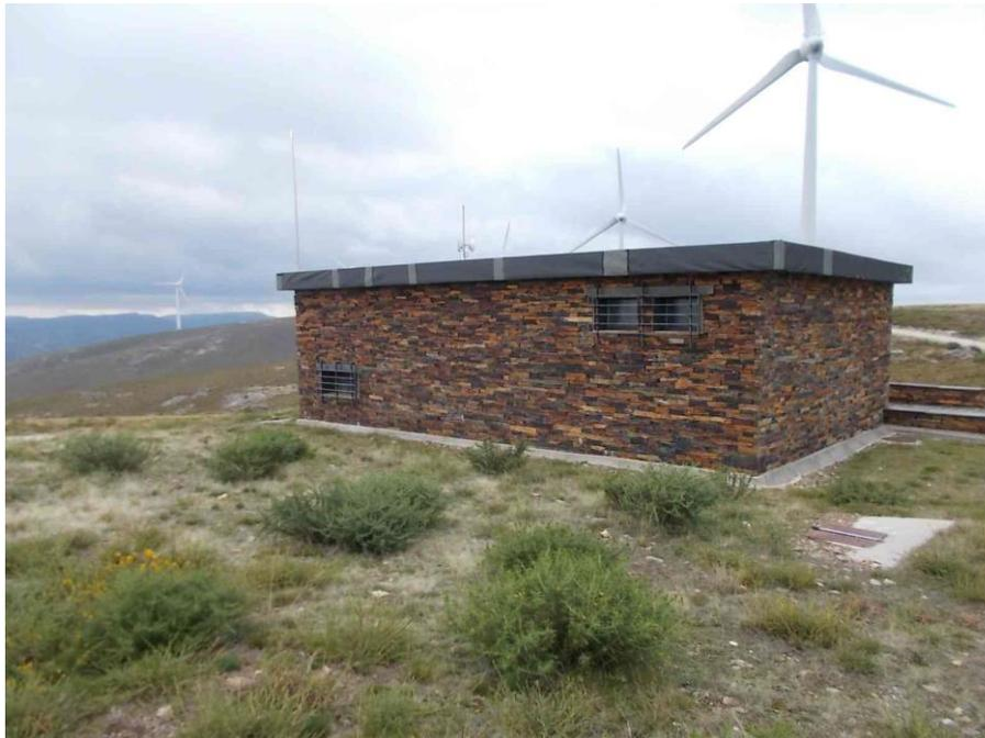
**Fotografia 3 – Posto de seccionamento existente e em exploração no núcleo da Coelhoira, ao qual os aerogeradores do Sobreequipamento irão ligar-se através de cabos subterrâneos.**
