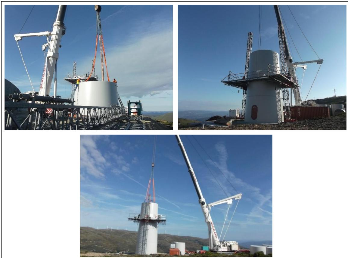
**Fotografia 10 - Montagem de uma torre de aço.**
