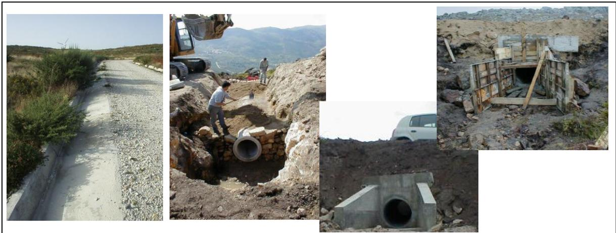
**Fotografia 6 – Valeta e construção de uma passagem hidráulica.**
