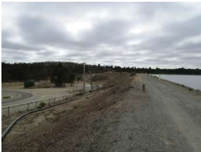
Figura 9 - Vista geral do terreno, na área a Norte do coroamento da BAI
