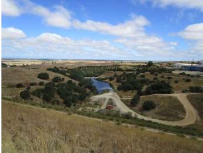
Figura 8 - Vista geral da zona de descarga de emergência
