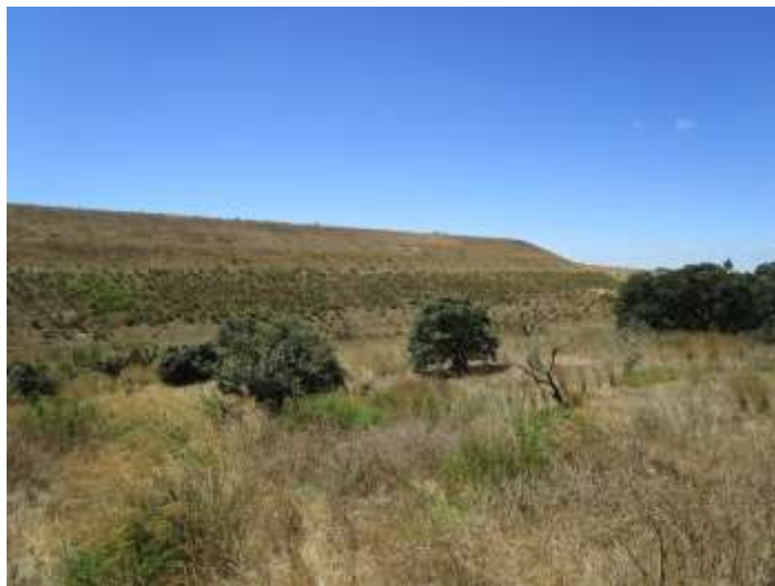
Figura 2 - Vista geral do alteamento da BE-BAC
