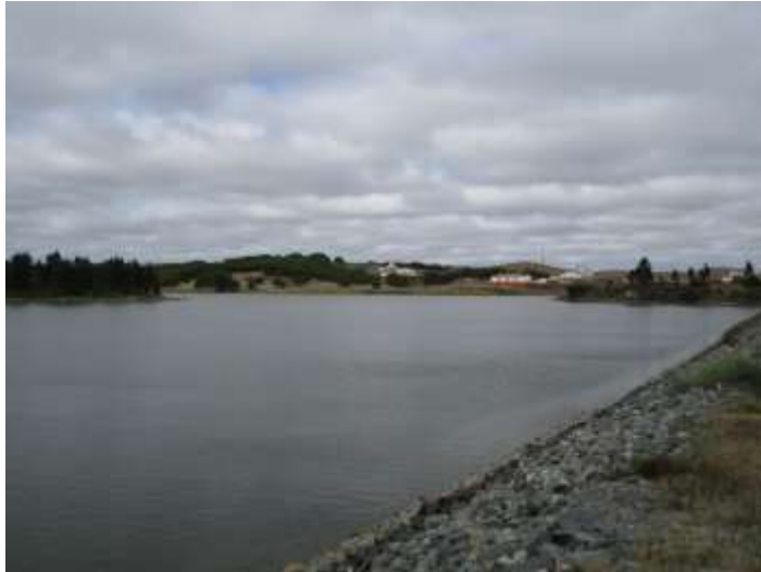
Figura 11 - Vista geral da área vedada ao acesso público
