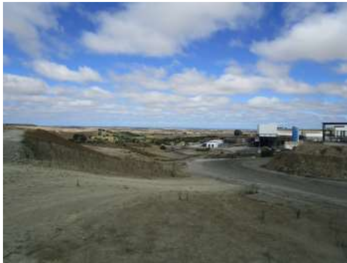
Figura 1 - Vista geral do terreno, no setor a norte do alteamento da BE-BAC
