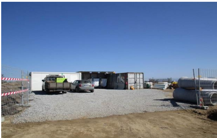
Fotografia 3 – Exemplo de um estaleiro a instalar.
