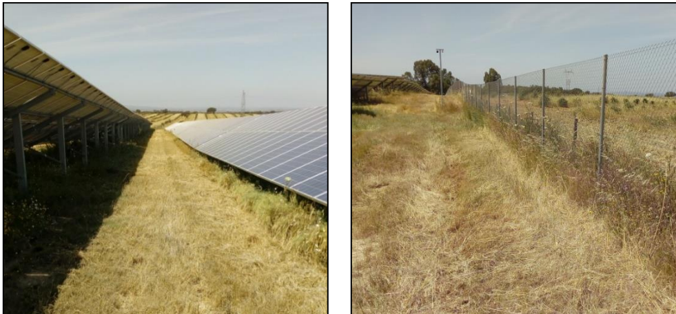
Fotografias 4 e 5 – Exemplo de caminhos entre fileiras de mesas de módulos fotovoltaicos e junto à vedação.
