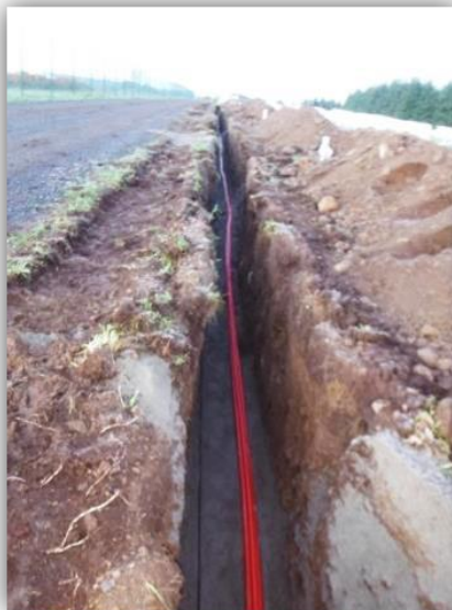
Fotografia 6 – Exemplo de vala para instalação de cabos elétricos.
