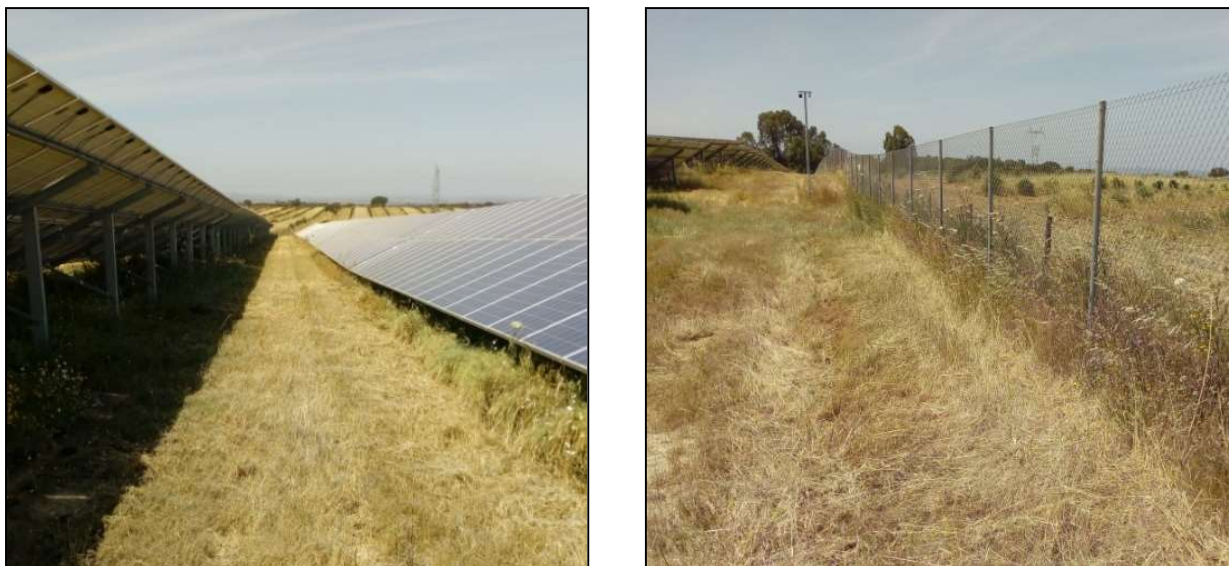
Figura 14.2 – Exemplo de caminhos entre fileiras de mesas de módulos fotovoltaicos e junto à vedação.
