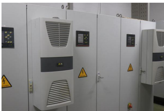
Figura 20 – Estação de Ozono.
