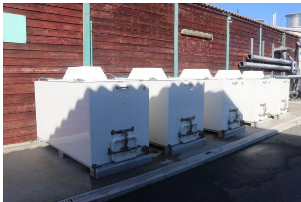
Figura 25 – Edifício principal de produção (01).
