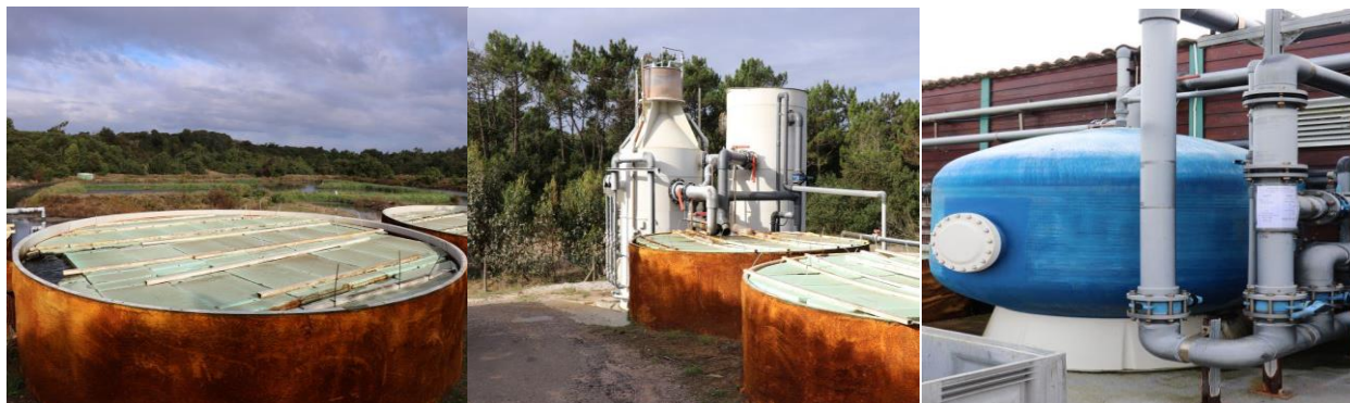
Figura 14 – A - Tanques de remoção do ferro; B – Sistema de desinfecção inicial; C – Filtro de Carvão Ativo.
