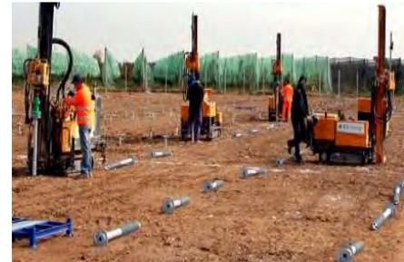
Perfuração do solo para execução da fundação da estrutura
