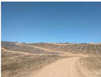
Terreno preparado com estruturas metálicas para suporte de seguidores solares de um eixo
