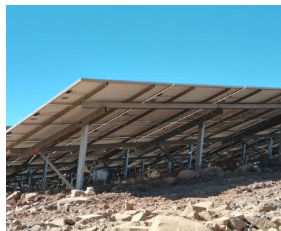
Fotografia 3: Exemplo de estrutura metálica das mesas
