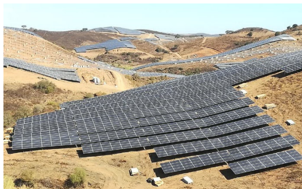
Fotografia 1 – Exemplo de uma Central Solar Fotovoltaica em construção
