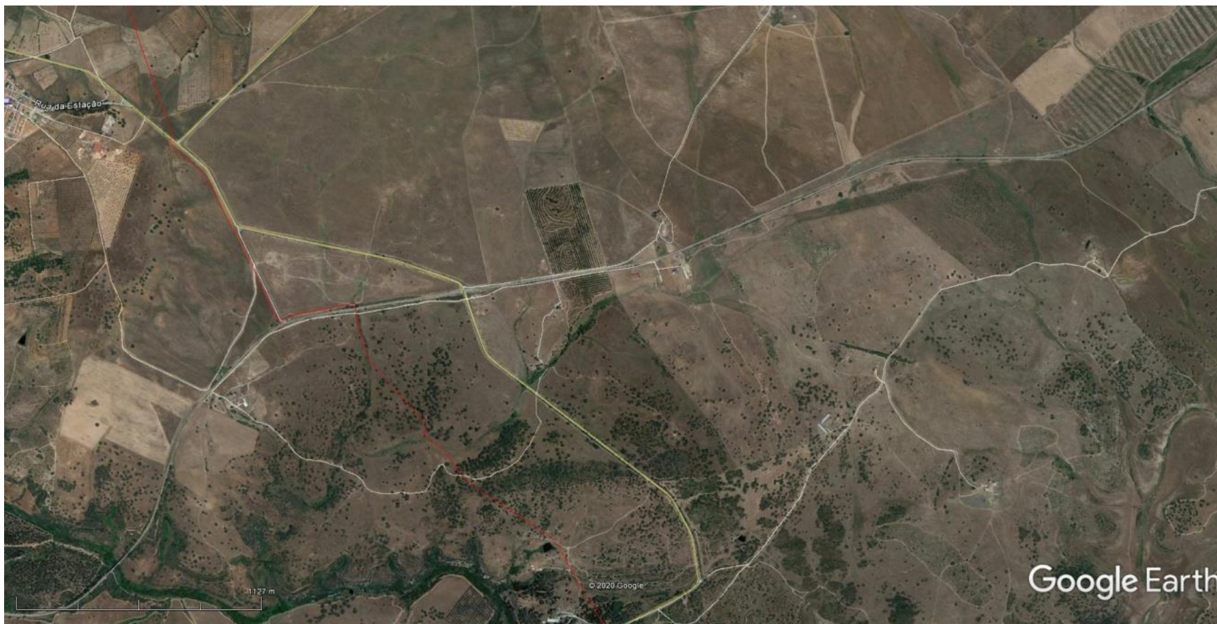
Figura 4.15.5 – Imagem aérea da conduta adutora, junto à Barragem do Monte da Rocha (Fonte: Coba, 2021; Google Earth, 2021)
