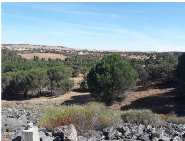
Fotografia 4.11.1 – Aspeto geral da paisagem para norte da barragem do Monte da Rocha, na direção de Panóias.
