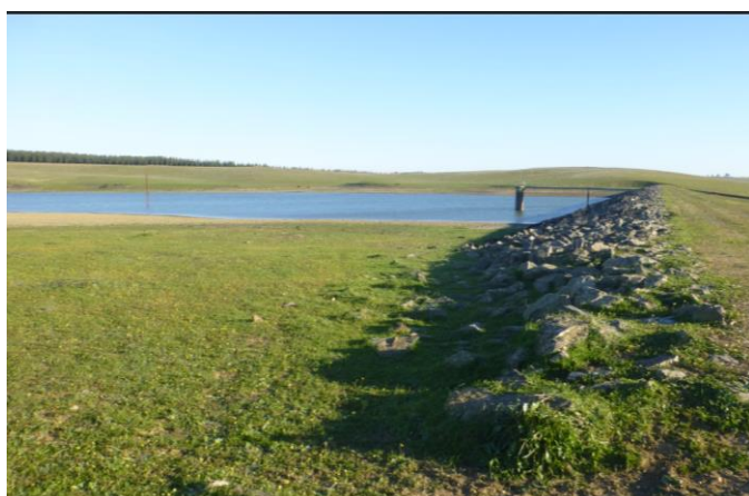
Fotografia 4.8.3 - Barragem na ribeira dos Miguéis
