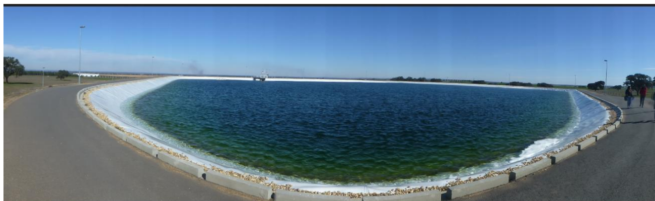
Fotografia 4.8.2 - Reservatório R3 de Rio de Moinhos (EDIA)
