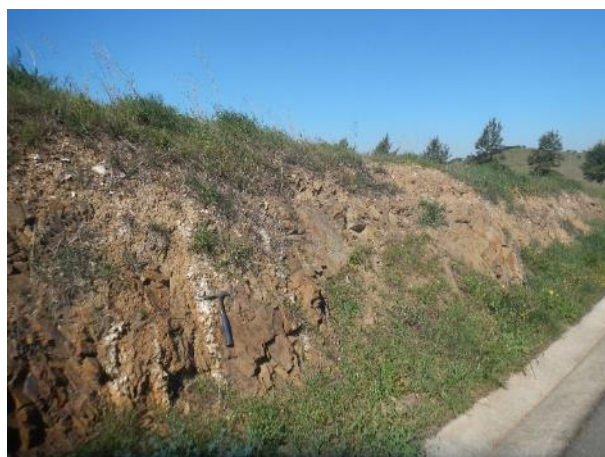
Fotografia 4.5.20 – Afloramento rochoso no talude de escavação da EM1082, junto da futura travessia
