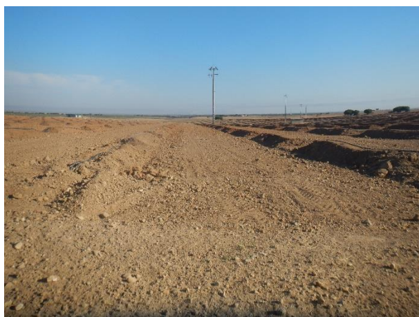
Fotografia 4.5.1 – Vista geral da área interessada pela futura Estação Elevatória
