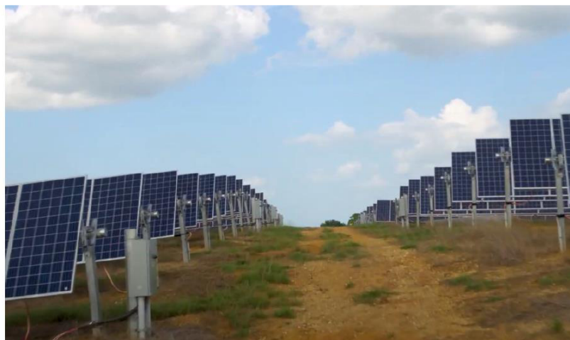
FIGURA 4 – Exemplo de seguidores a instalar na Central Fotovoltaica.
