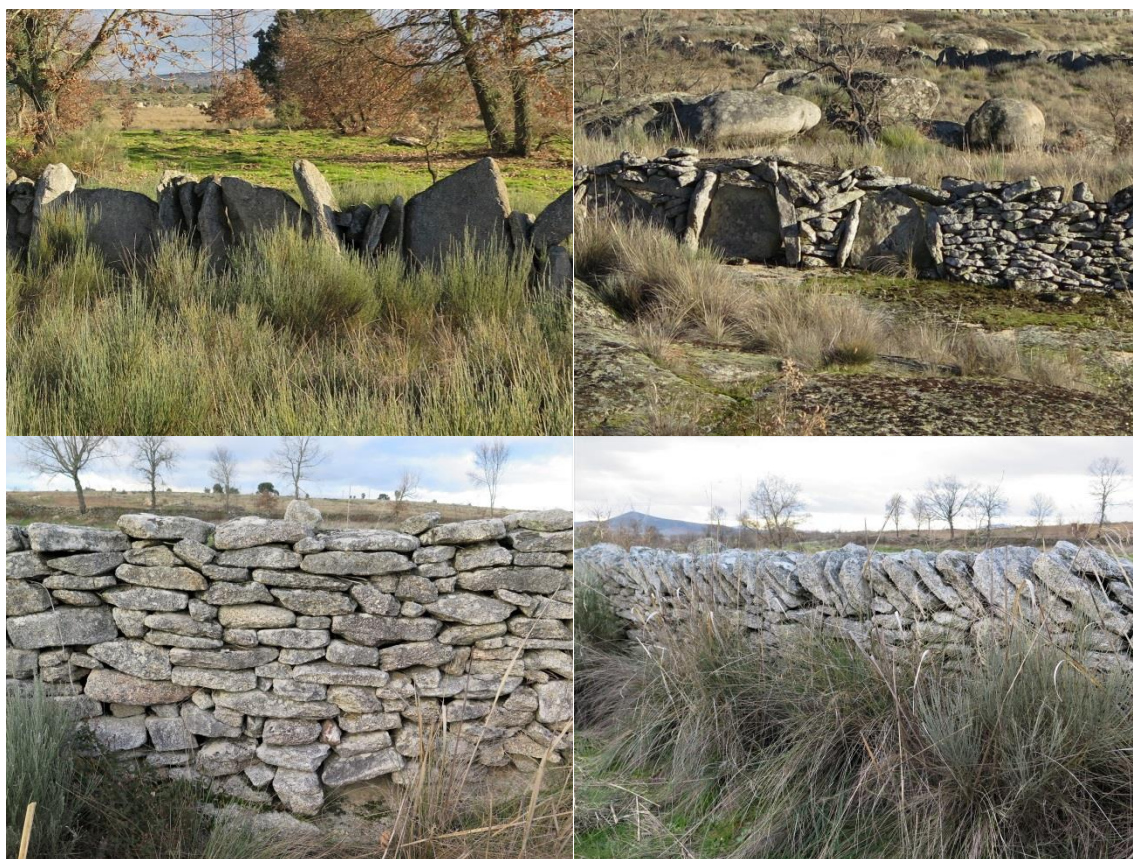
Fotografia 6.38 – Tipologia de muros existentes na área de estudo da Central Fotovoltaica de Lagoaça.
