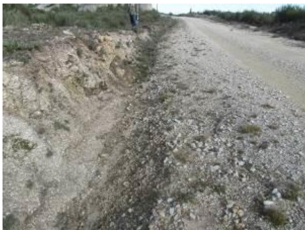
Fotografia 4.7 e Fotografia 4.8 – Exemplo de valetas sem revestimento, observando-se à esquerda como é efetuado o encaminhamento do escoamento para a linha de água mais próxima.
