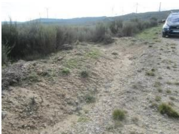
Fotografia 4.7 e Fotografia 4.8 – Exemplo de valetas sem revestimento, observando-se à esquerda como é efetuado o encaminhamento do escoamento para a linha de água mais próxima.
