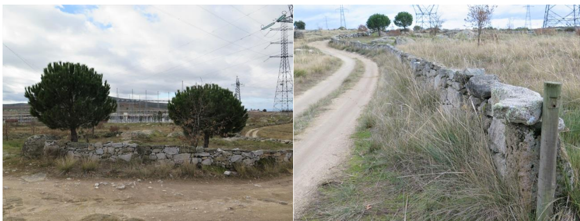
Fotografia 6.48 – Muros no corredor da Linha Elétrica nas imediações da Subestação de Lagoaça.
