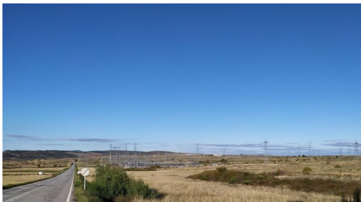
Fotografia 6.35 – Presença da Subestação da Lagoaça na área de estudo da paisagem.
