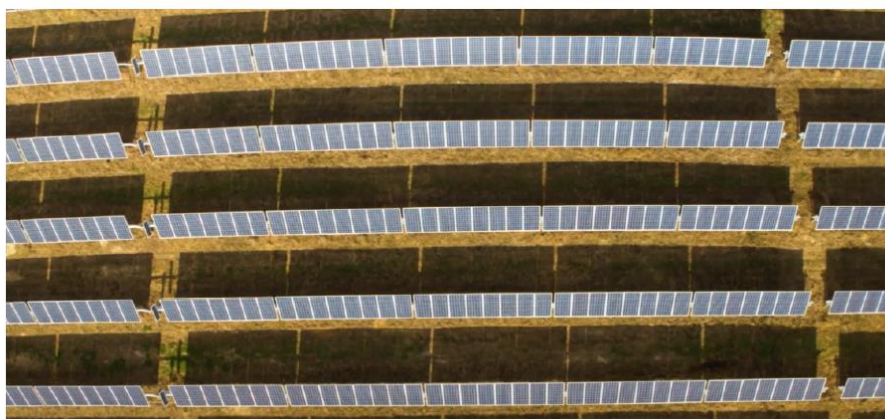
Fotografia 4.4 – Vista em planta dos seguidores.
