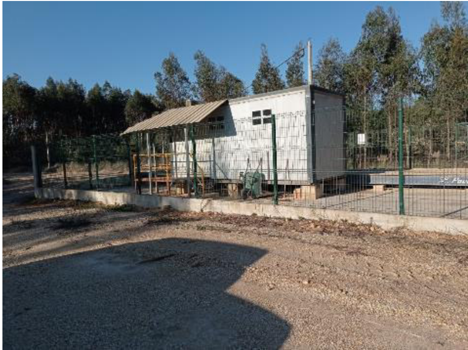
Figura 6: Báscula, edifício de apoio e linha elétrica. (visita da CA à Mina, 26 de novembro 2021)
