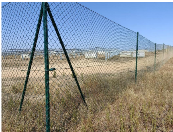
Fotografia 2 – Aspeto da vedação do PF do Pereiro 1.
