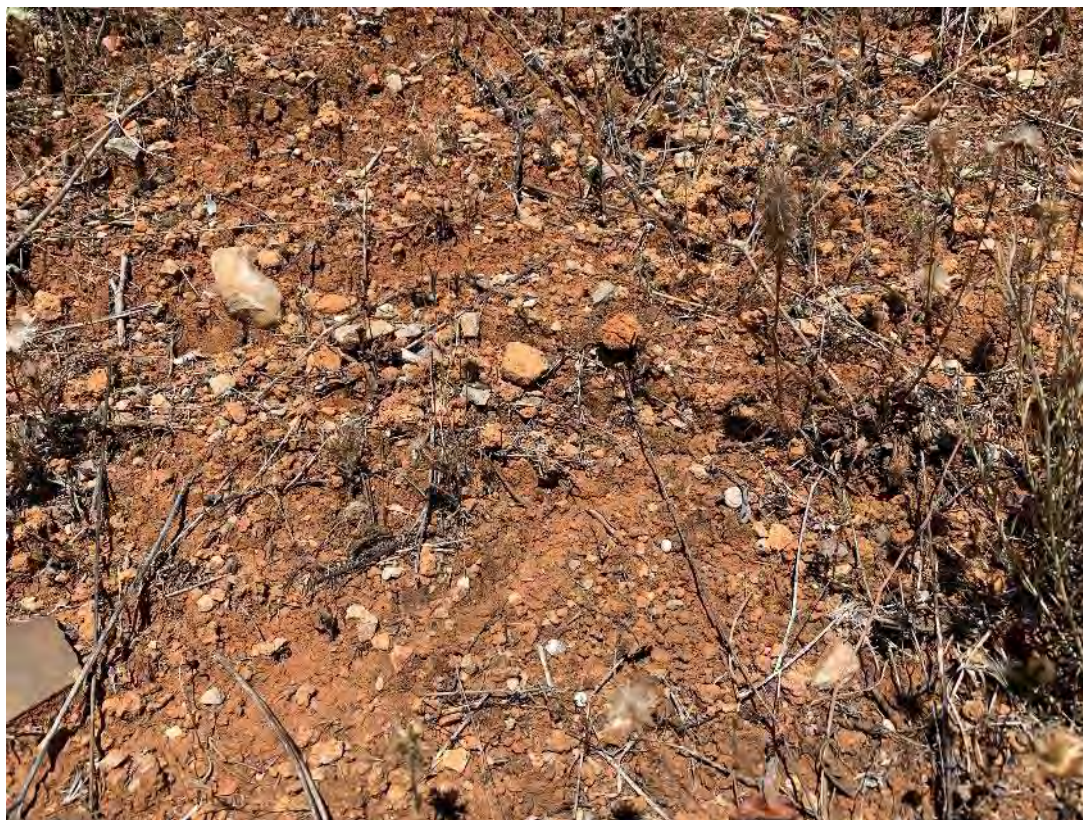
Imagem 10 – Talude da Rotunda dos Machados
