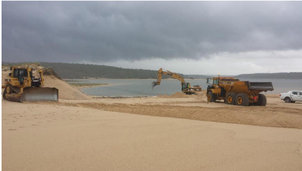
Figura 5. Operações de abertura da barra (Fonte: EIA/Câmara Municipal de Sesimbra 2018).
