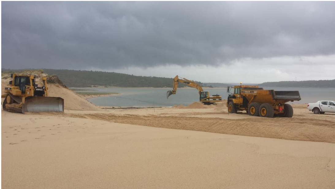
Fotografia 2 – Operações de abertura artificial da barra
