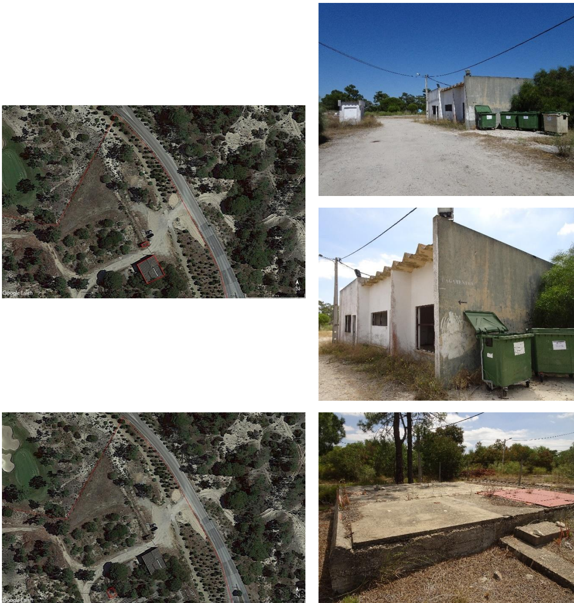
Figura 3 – Edificações (ou parte delas) que permanecem atualmente na parcela 2 da UNOP 3
