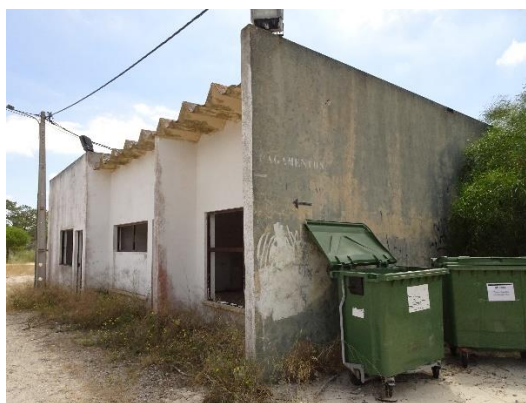
Figura 44 – Edificado do antigo parque de campismo
