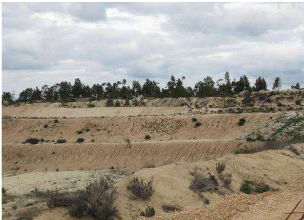
**Figura 15: Bloco C – Modelação de taludes após a exploração**
