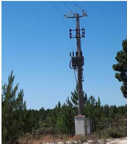
Fotografia 4.4 – Posto de transformação existente no exterior da propriedade
