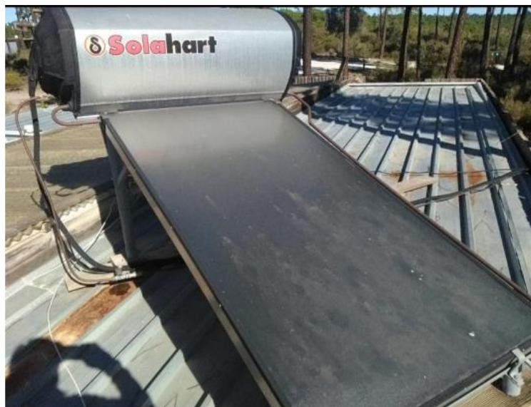
Fotografia 4.6 – Sistema solar térmico tipo termossifão
