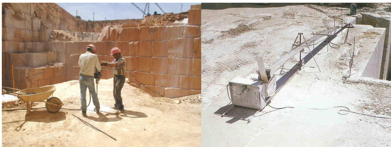
Figura 122. Operação de Perfuração e Corte numa pedreira de mármore.
