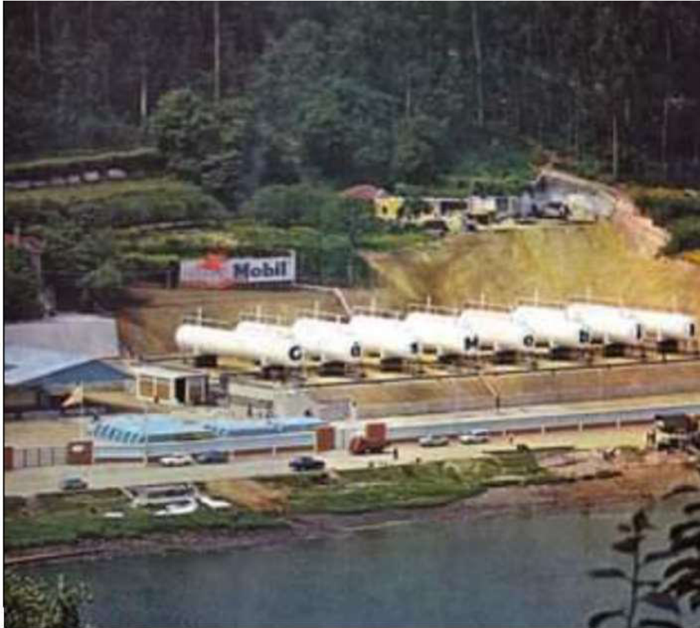
Figura 5 – Instalações da Mobil Oil Portuguesa, no Cais do Cavaco, 1964
