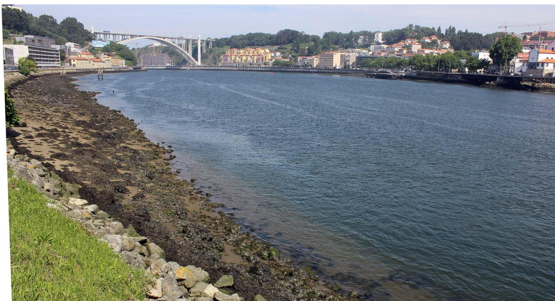
FIG. 6 - Área de intervenção em situação de baixa-mar de águas-vivas
