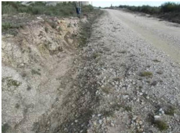
Fotografias 4.8 e 4.9 – Exemplo de valetas sem revestimento, observando-se à esquerda como é efetuado o encaminhamento do escoamento para a linha de água mais próxima
