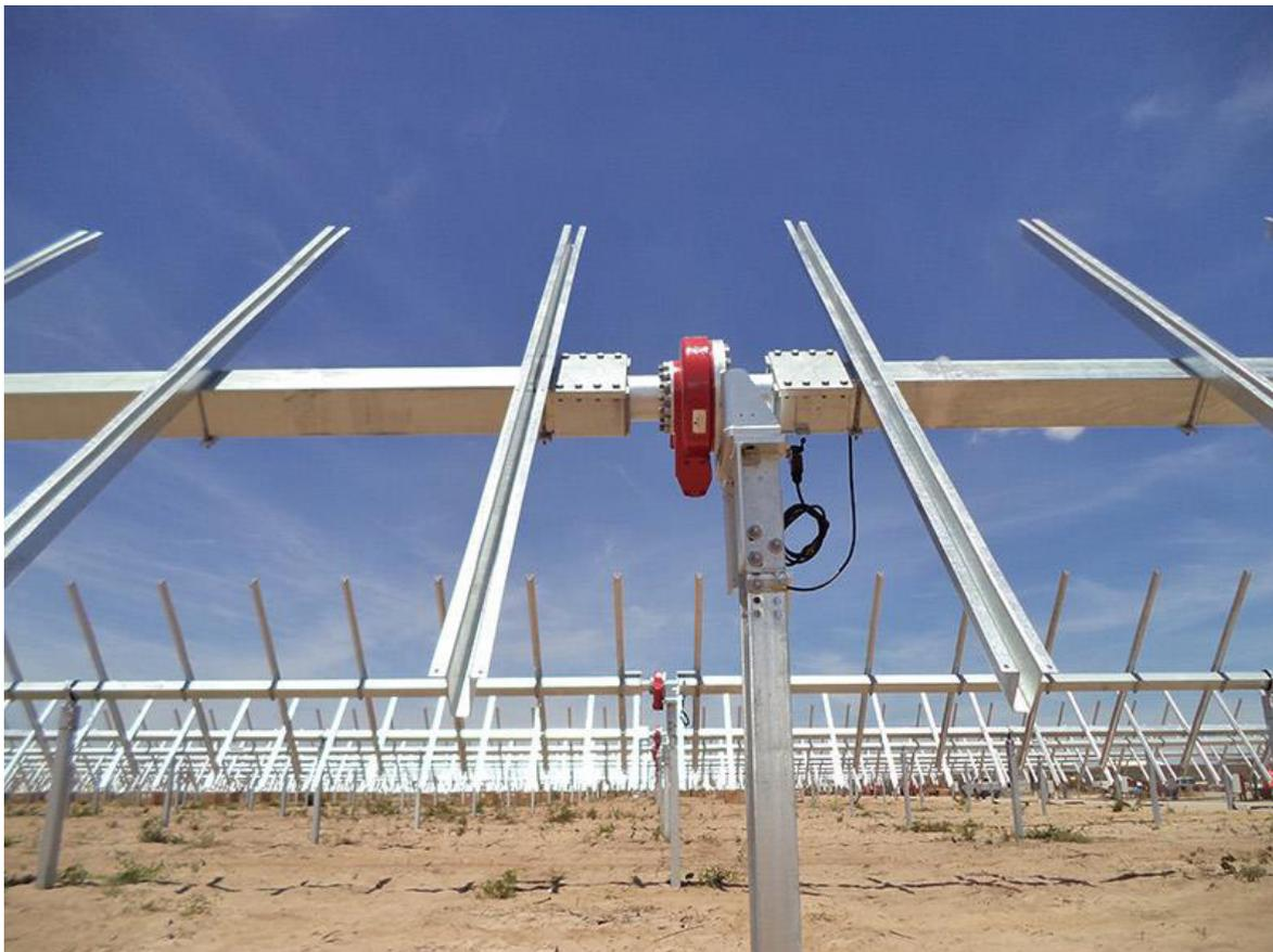
Fotografia 4.16 – Estrutura de suporte de painéis fotovoltaicos (fixa ao solo) (Fonte: <https://soltec.com/>)
