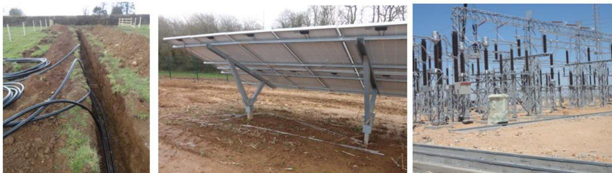
Fotografias 4.2, 4.3 e 4.4 – Exemplo de algumas fases durante a construção de uma central fotovoltaica
