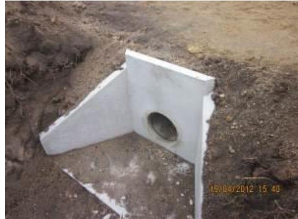
Fotografias 4.10 e 4.11 – Exemplo da descarga de uma passagem hidráulica (boca de saída)
