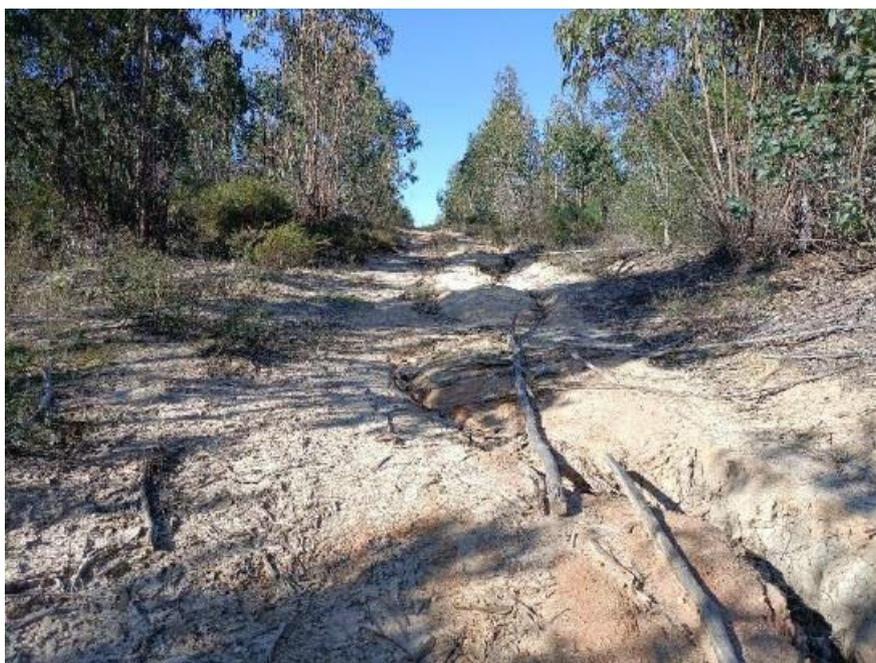
Fotografia 6.7 – Processos erosivos gerados por escoamento superficial (sulcos) em troço de caminho de terra batida
