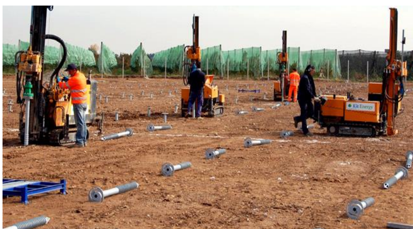
Fotografia 4.2 – Maquinaria utilizada para a perfuração.
