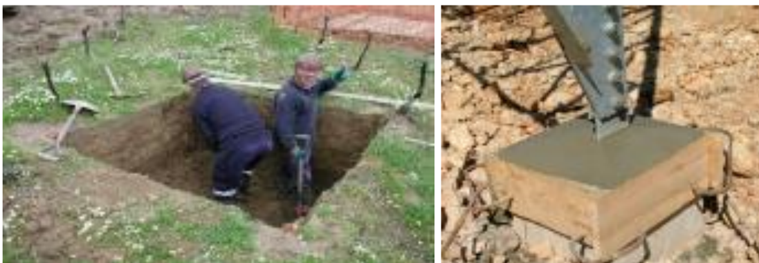
Figura 4.9 – Tipo de fundações para os apoios.
