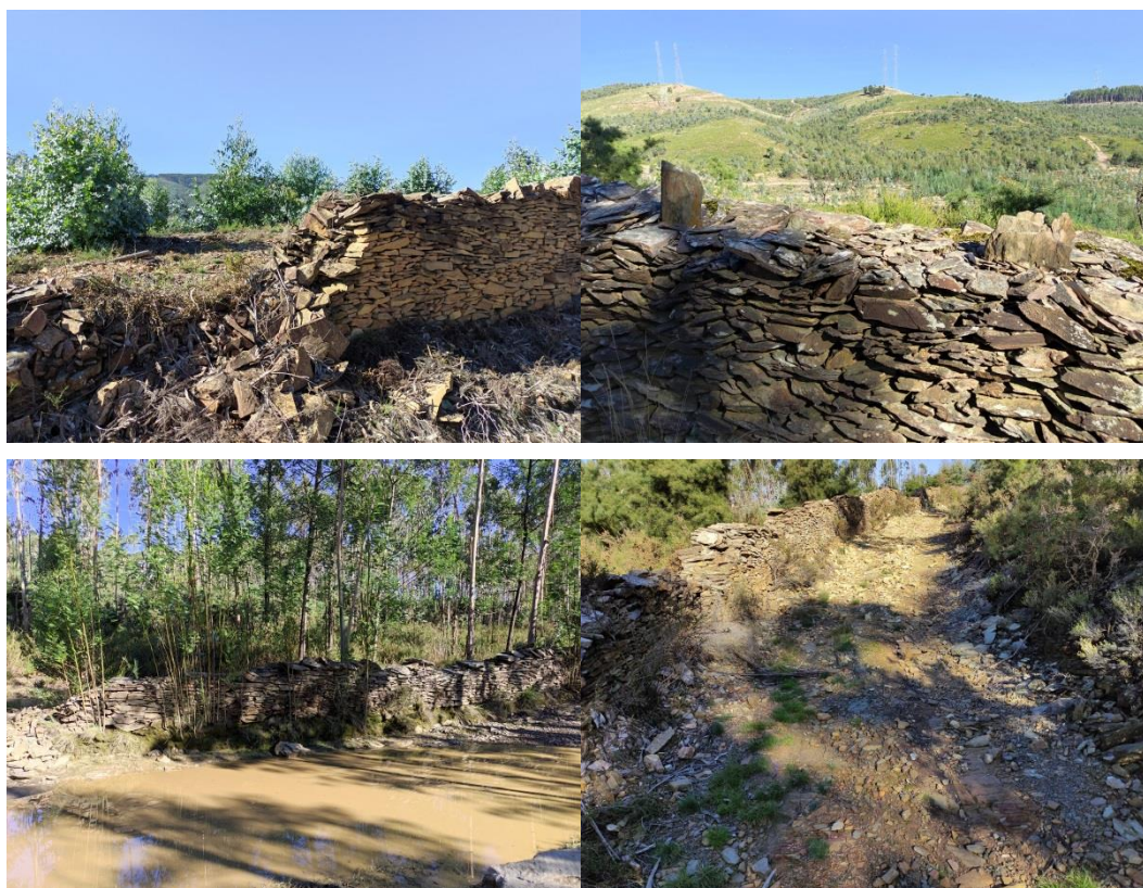
Fotografia 6.17 – Pormenores de muros de pedra seca.
