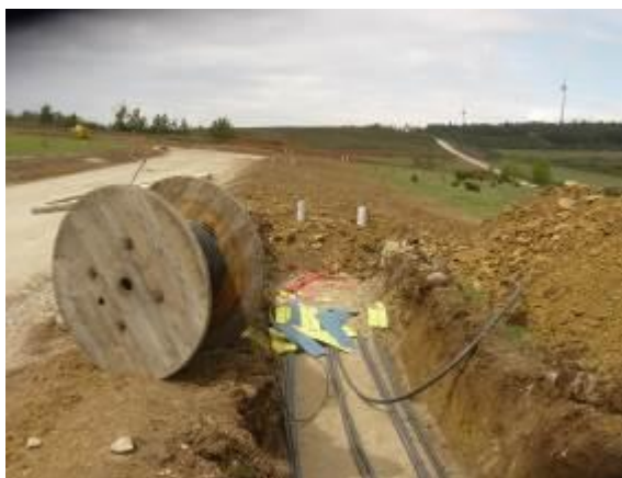
Fotografia 4.4 e Fotografia 4.5 – Exemplo de vala para instalação de cabos elétricos.
