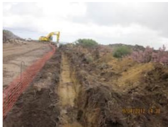
Fotografia 4.4 e Fotografia 4.5 – Exemplo de vala para instalação de cabos elétricos.
