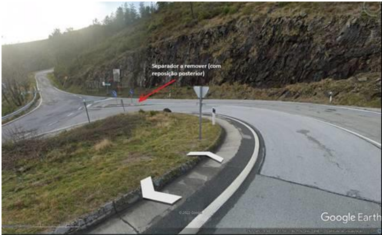
Figura 17 – Exemplo de intervenção na saída do IP4.
