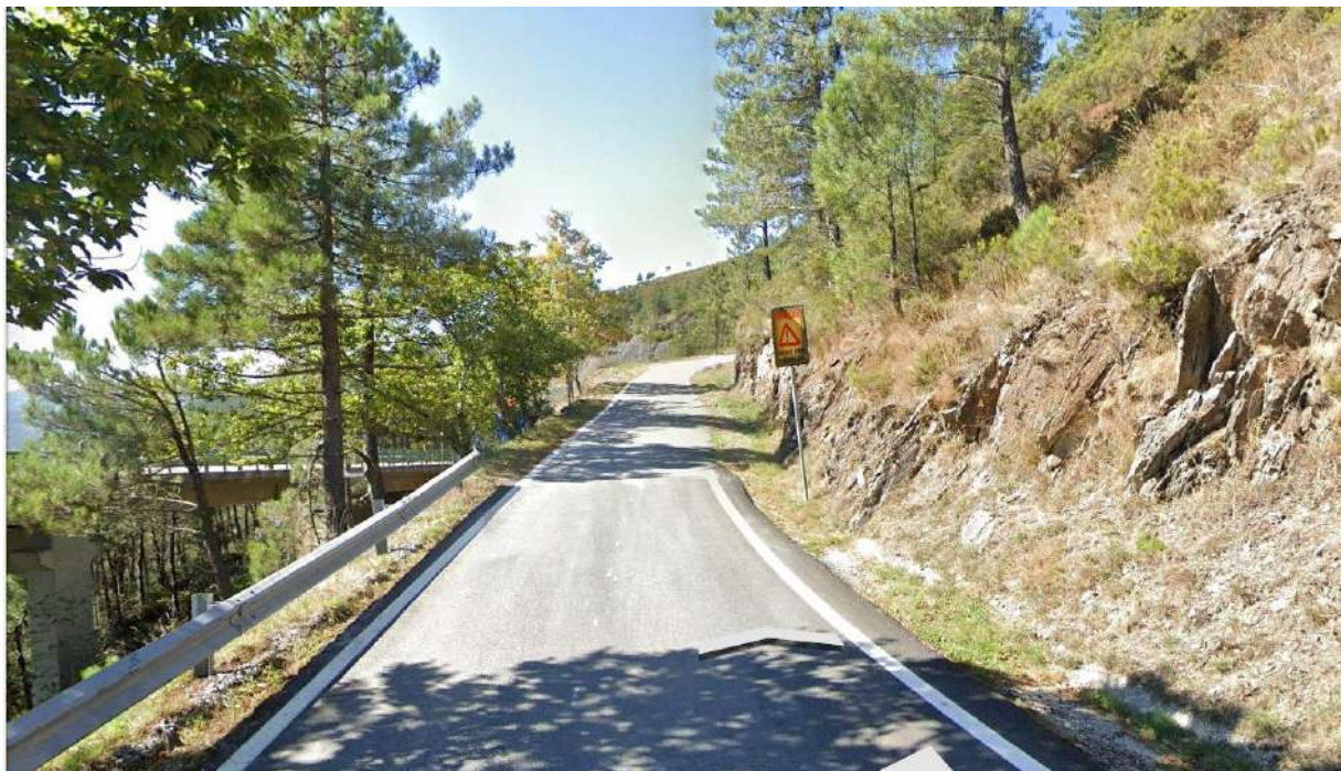
Foto 2 - EN15, Início do troço asfaltado em direcção à Lameira
