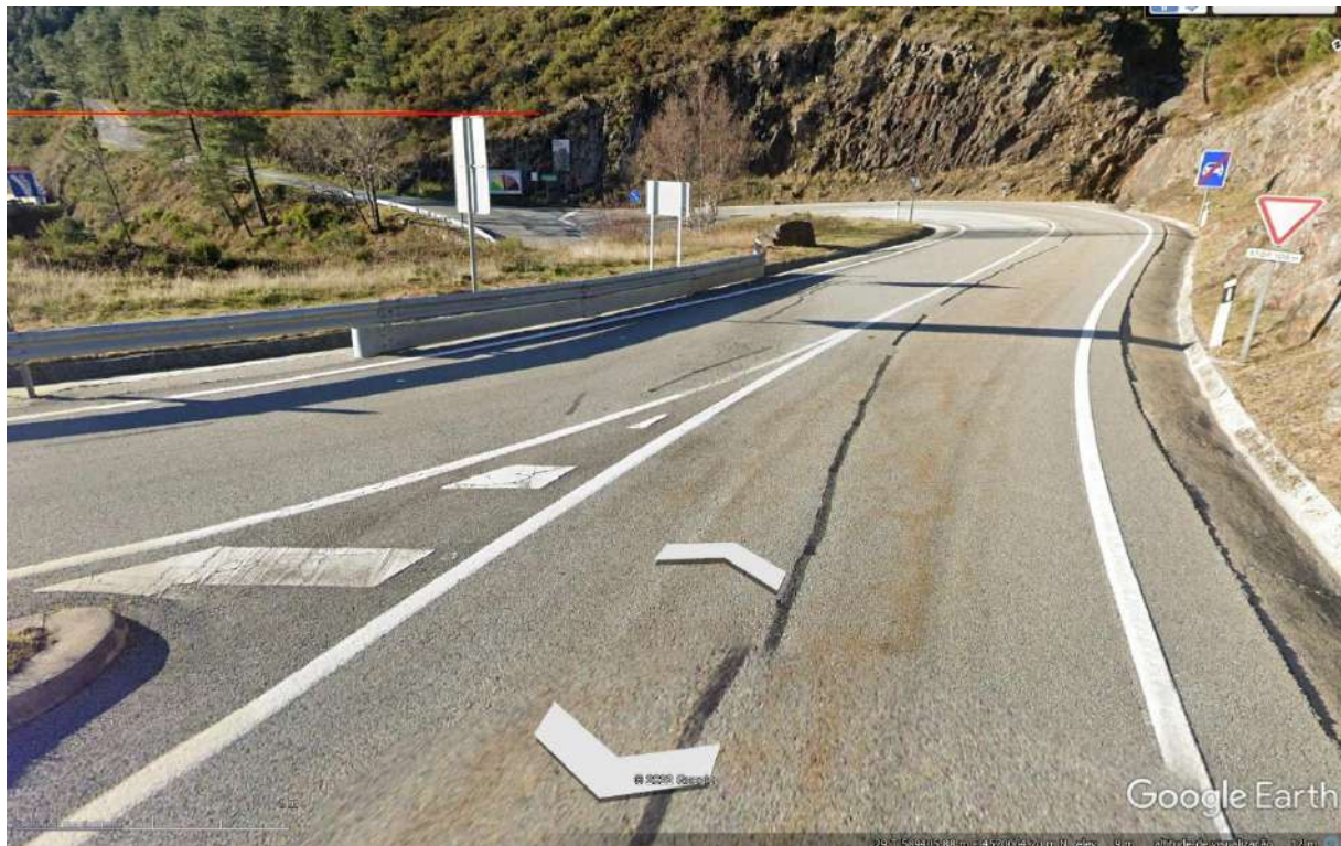
Foto 1 - Saída do IP4 para a EN15, cerca do km 74.
