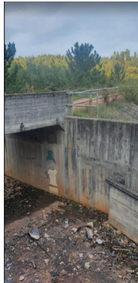
Figura 1: Canal de escoamento a jusante da albufeira de Sobrena.
