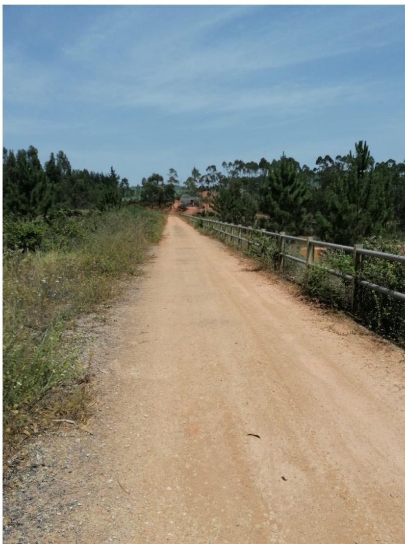
Figura 9. Passagem superior do açude da albufeira de Sobrena.
