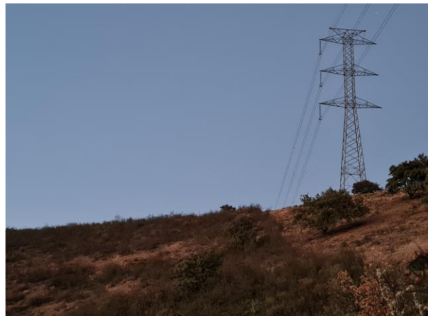
Figura 4.3.32 – Área de arborização do apoio P20
