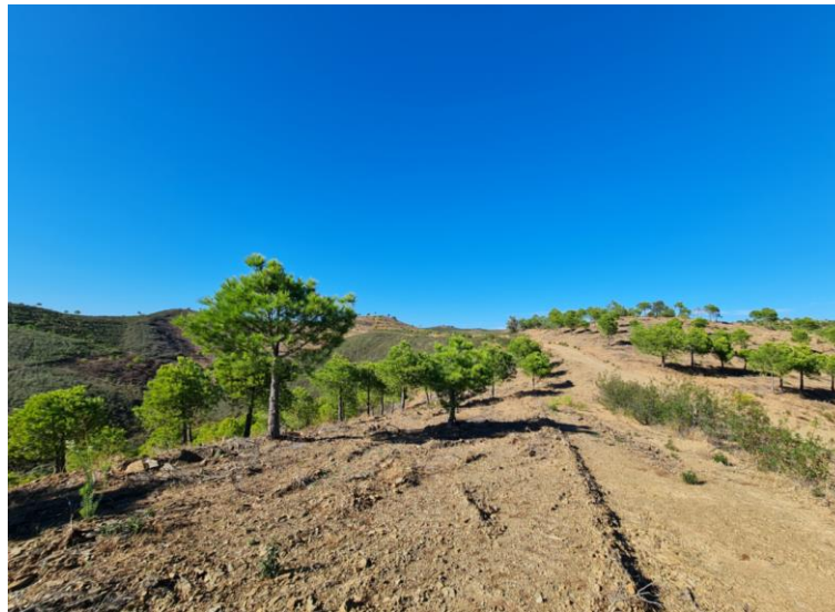
Figura 4.3.19 – Acesso existente a manter ao apoio P12
