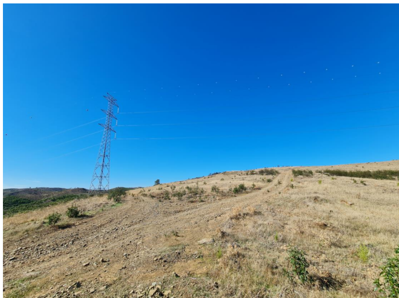
Figura 4.3.17 – Acesso existente a manter ao apoio P11
