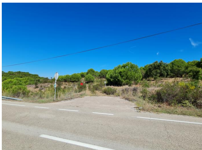
Figura 4.3.47 – Acesso existente a manter ao apoio P29
