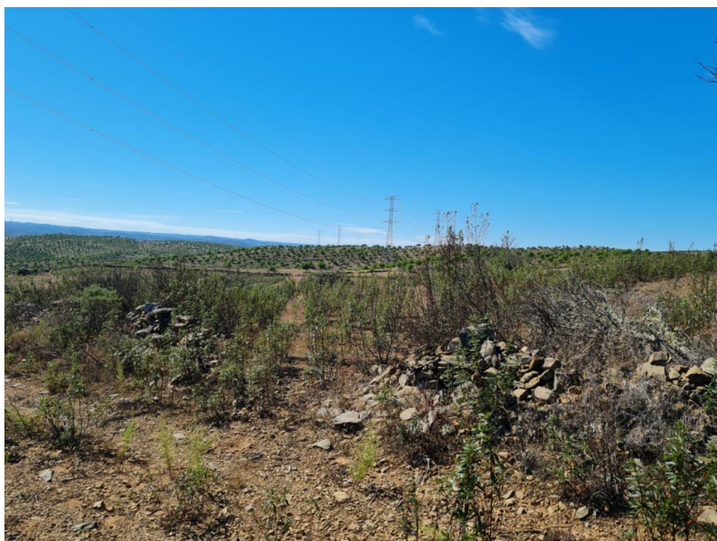
Figura 4.3.10 – Muro em pedra existente.
