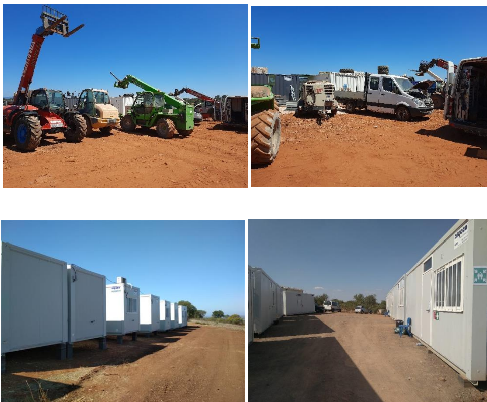
Fotografia 2.9 – Operação de Estaleiro e Maquinaria de Obra
