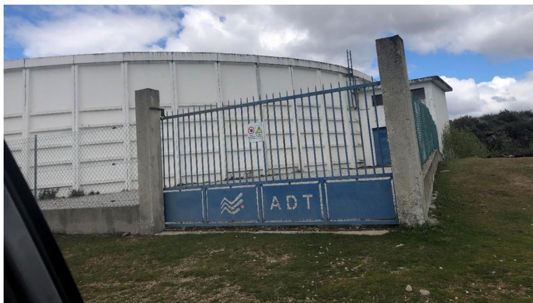
Fotografia 2.4 – Reservatório ADT existente no interior da Área de Estudo
