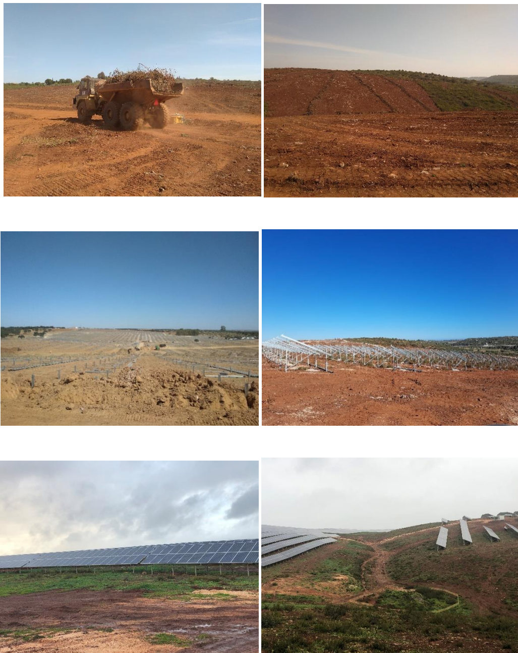
Fotografia 2.10 – Desmatamento, decapagem e cravação de perfis metálicos da estrutura seguidora
