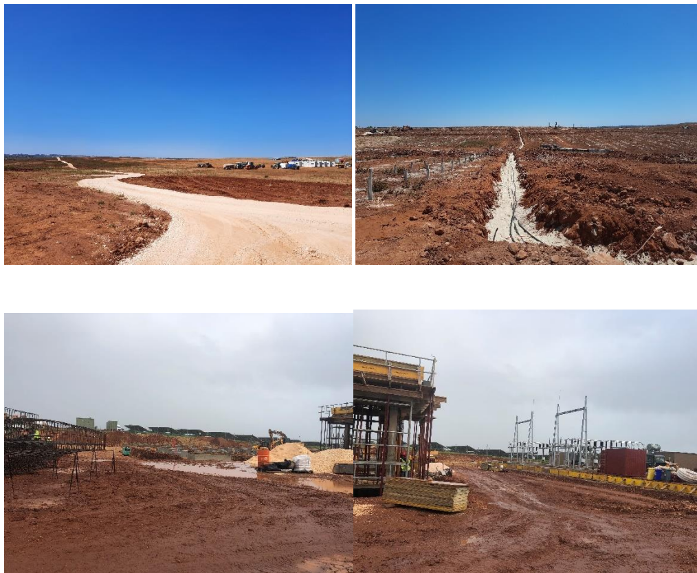
Fotografia 2.11 – Ações construtivas dos diversos elementos: acessos, passagens hidráulicas, valas técnicas, subestação e vedação
