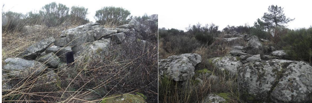
Fotografia 5.1 - Muro de pedra solta na extrema sul da área de intervenção
