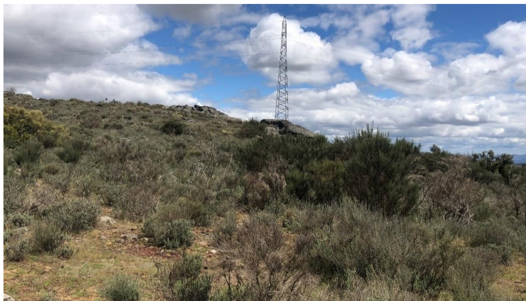
Fotografia 2.2 – Linha Elétrica de AT associada ao Atual Parque Eólico de Trancoso, inserida no interior da área de implantação da Central Fotovoltaica
