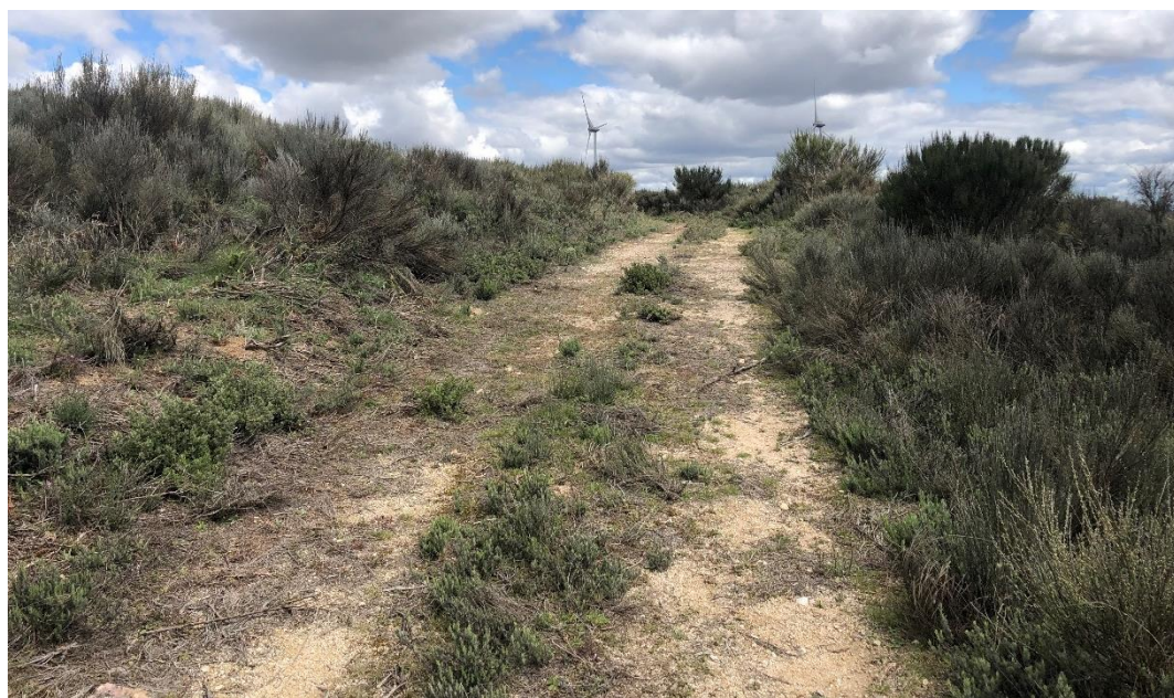
Fotografia 2.5 – Exemplo de um acesso a beneficiar no âmbito do projeto
