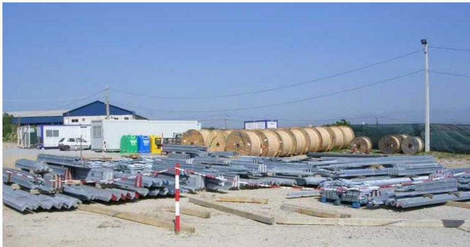
Fotografia 4.2 – Estaleiro de apoio à obra de construção de uma linha semelhante à em análise
