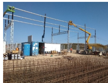
Exemplo da obra da subestação numa Central Fotovoltaica
