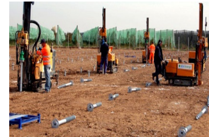
Perfuração do solo para execução da fundação da estrutura
