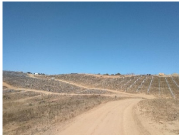
Terreno preparado com estruturas metálicas para suporte de seguidores solares de um eixo
