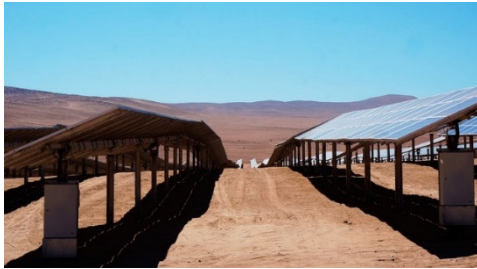
Exemplo de uma Central Fotovoltaica com módulos que acompanham o relevo
