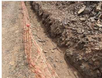
Exemplo da abertura da vala para cabos elétricos
