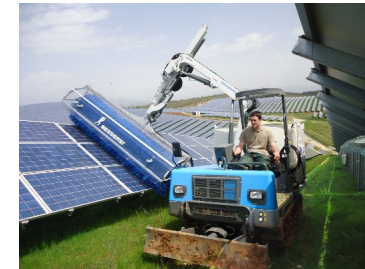
Limpeza dos painéis fotovoltaicos na fase de exploração
