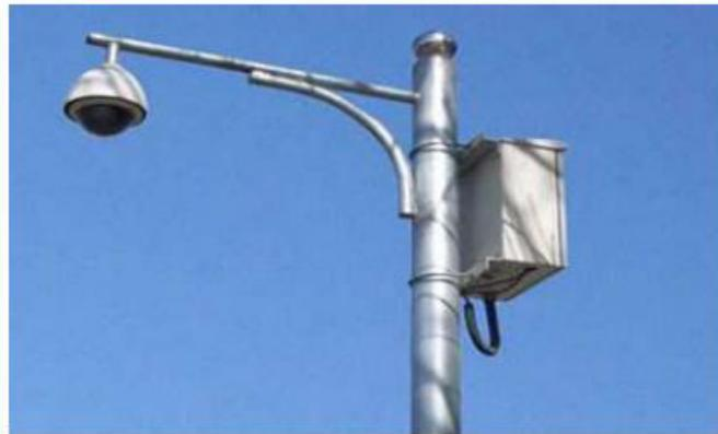
Figura 4.12 – Exemplo de câmara de videovigilância
