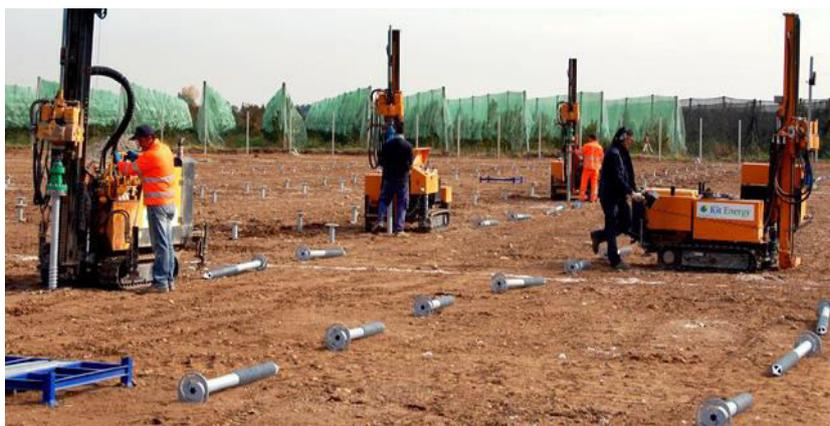
Fotografia 4.7 – Maquinaria utilizada para a perfuração
