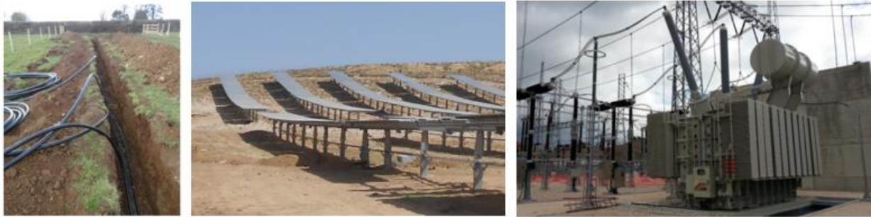
Figura 6 - Momentos da fase de construção da Central.
