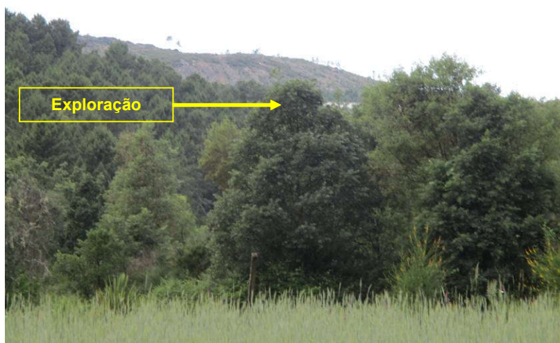
Foto 30 – Vista para a exploração a partir da habitação mais próxima (nascente). Exploração não visível.
