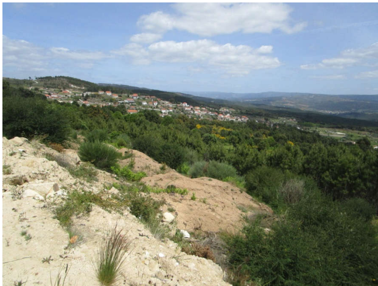
Foto 16 – Vista geral dos aterros que encostam ao talude dos pavilhões
