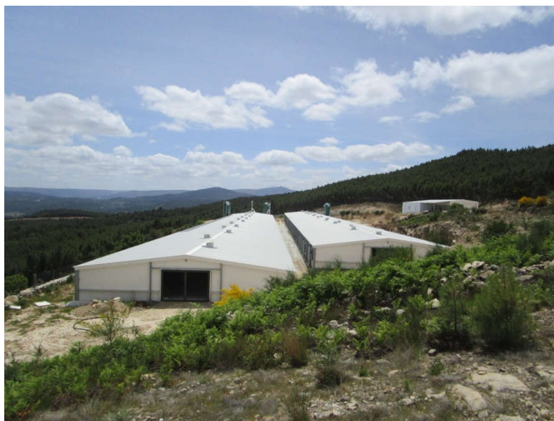
Foto 14 – Vista geral dos pavilhões já construídos (solo artificializado)
