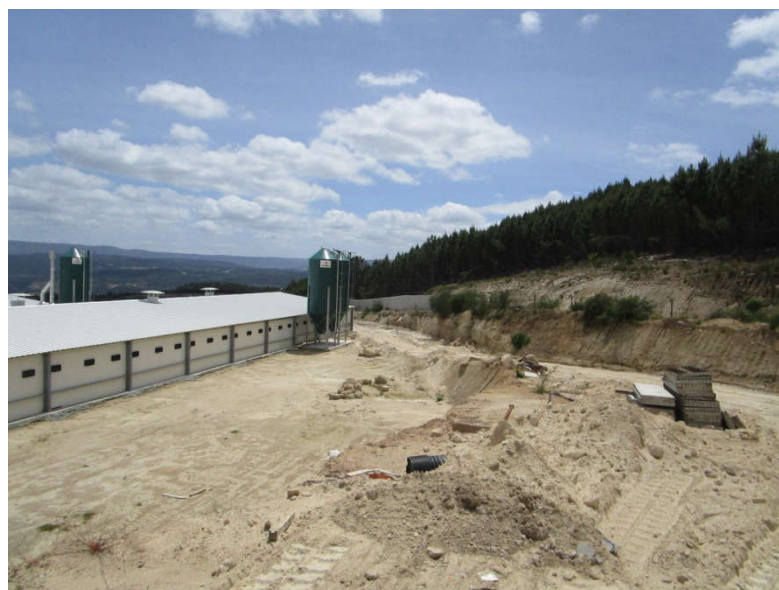
Foto 15 – Vista geral dos pavilhões já construídos e dos acessos
