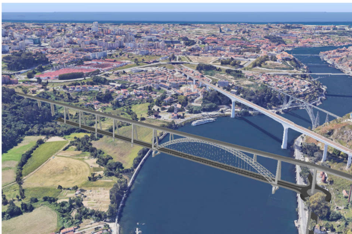
Figura 2 – Vista geral de Ponte de São João
