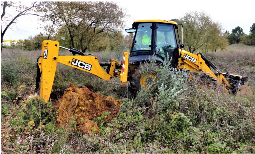
Figura 7 – Execução do poço de prospeção P4.
