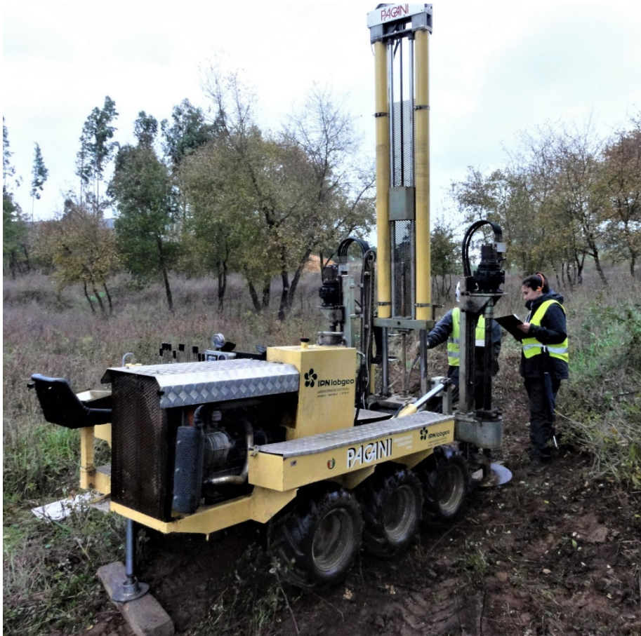
Figura 8 – Execução do PDSP3.
